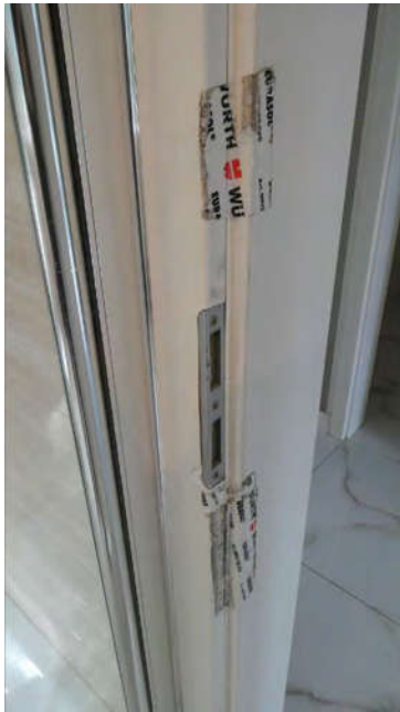
Bild 25: Bad , Situation Türrahmen
