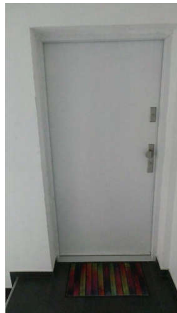
Bild 16: Bereich Wohnungseingang Bewertungsobjekt
