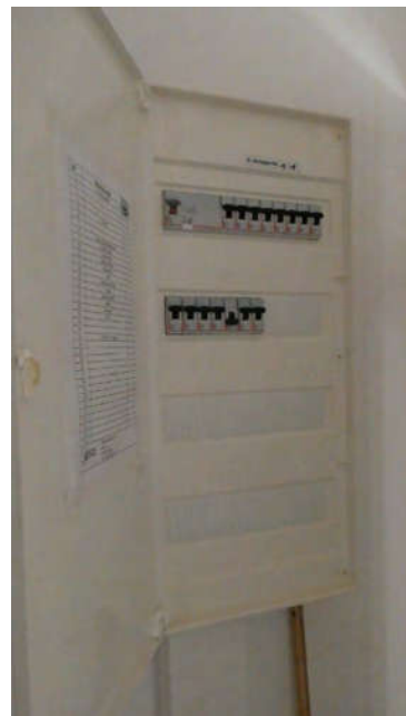
Bild 28: Abstellraum, Situation Elektrik
