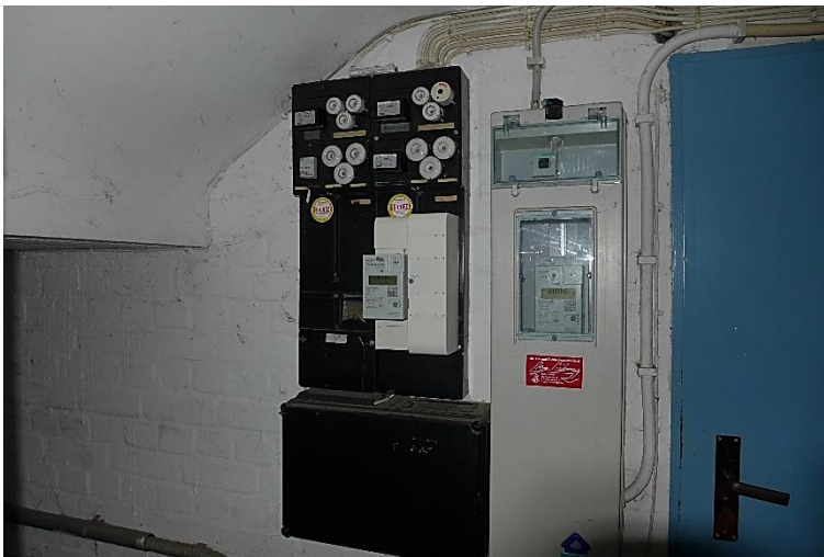
23. Stromzähler /Sicherungen
