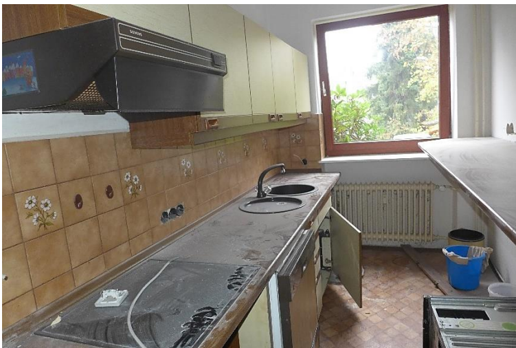
27. Küche – im Umbau
