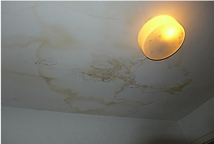
16. Feuchtigkeit an der Decke
