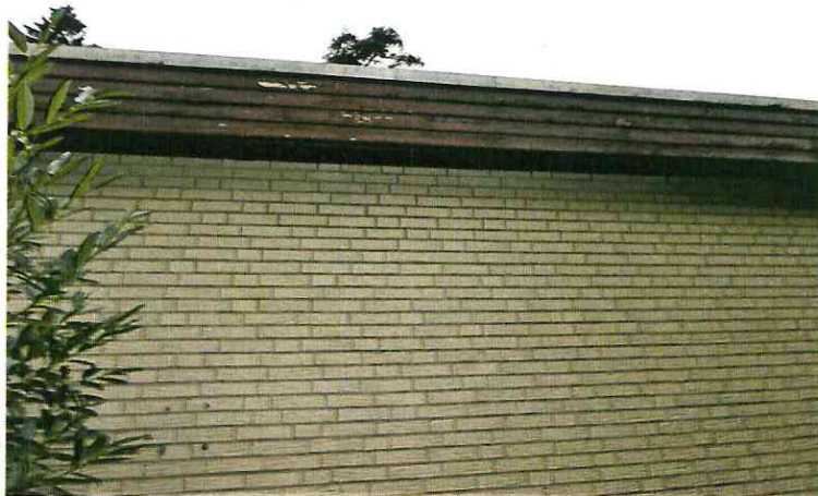
Bild 20: Farbabplatzungen Dachüberstand
