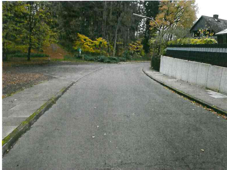
Bild 4: Umfeld in nördlicher Richtung
