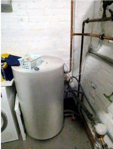
Bild 29: KG Warmwasserspeicher
