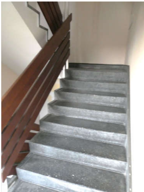
Bild 11: Bereich Treppenhaus Etage
