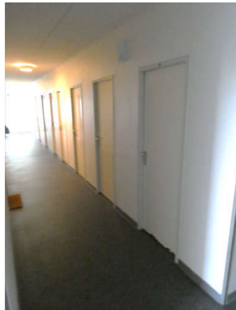
Bild 16: Bereich 5.OG Treppenhausflur Abstellräume
