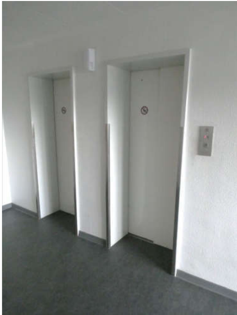
Bild 17: Bereich 5.OG Treppenhausflur zugehöriger Abstellraum (links)
