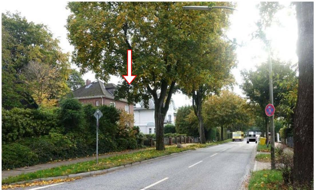
■ Straßenraum Röttgers Mühle / Rissener Landstraße (unten)
