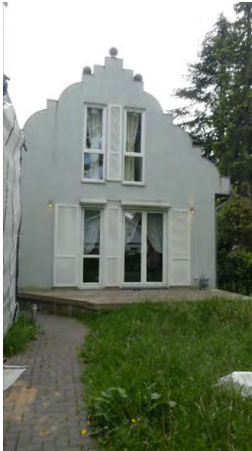
Bild 5: Ansicht Gebäudevorderseite mit Garten
