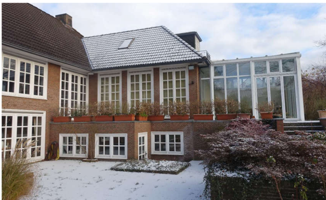
Außenanlagen (Treppe zur Einliegerwohnung / Garagenzufahrt / Gartenterrassen mit Garagenausgang)
