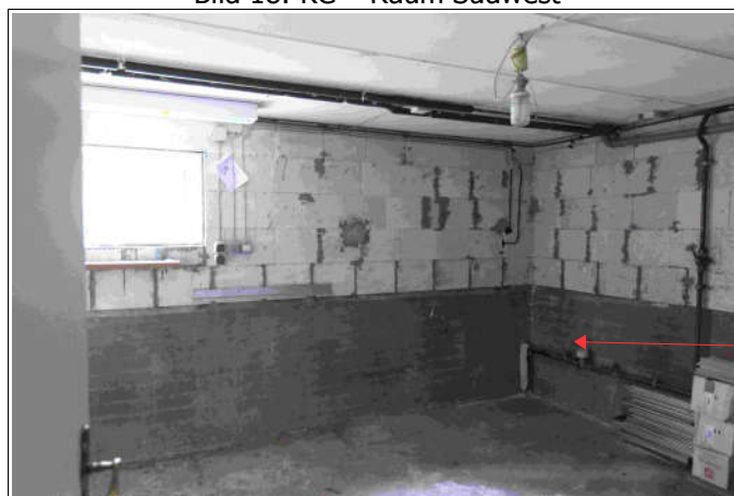
Bild 18: KG – Raum Südwest
