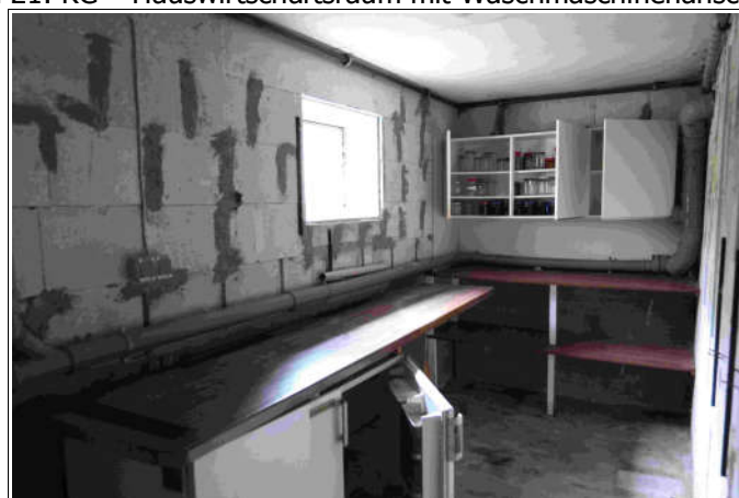
Bild 21: KG – Hauswirtschaftsraum mit Waschmaschinenanschluss
