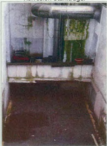
Korrosion Stahlträger
