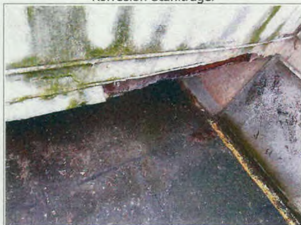
Korrosion Stahlträger
