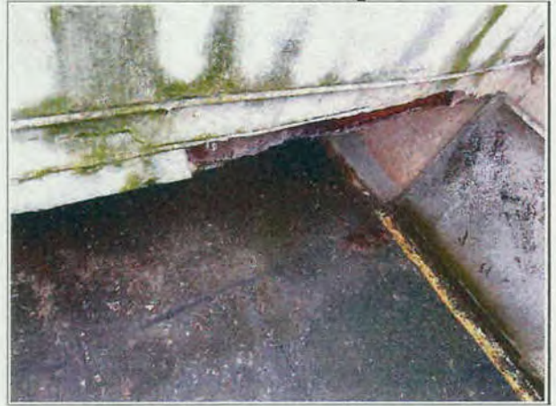
Korrosion Stahlträger
