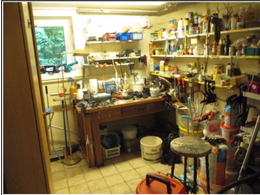
Bild 39 (Keller, Heizungsraum mit Werkstatt)
