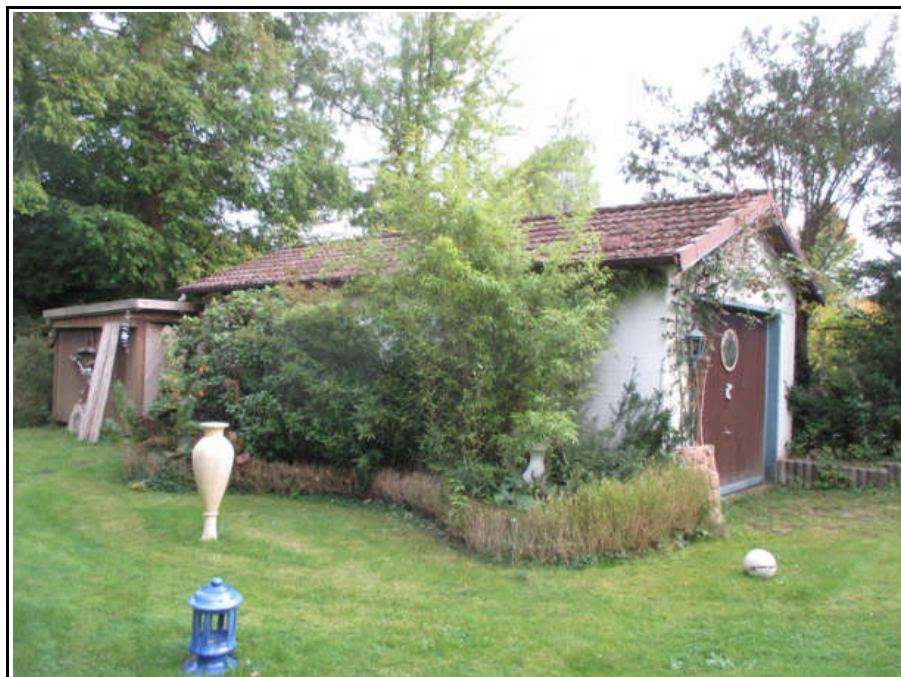
Bild 52 (Garage mit Carportanbau, links Mammutbaum)
