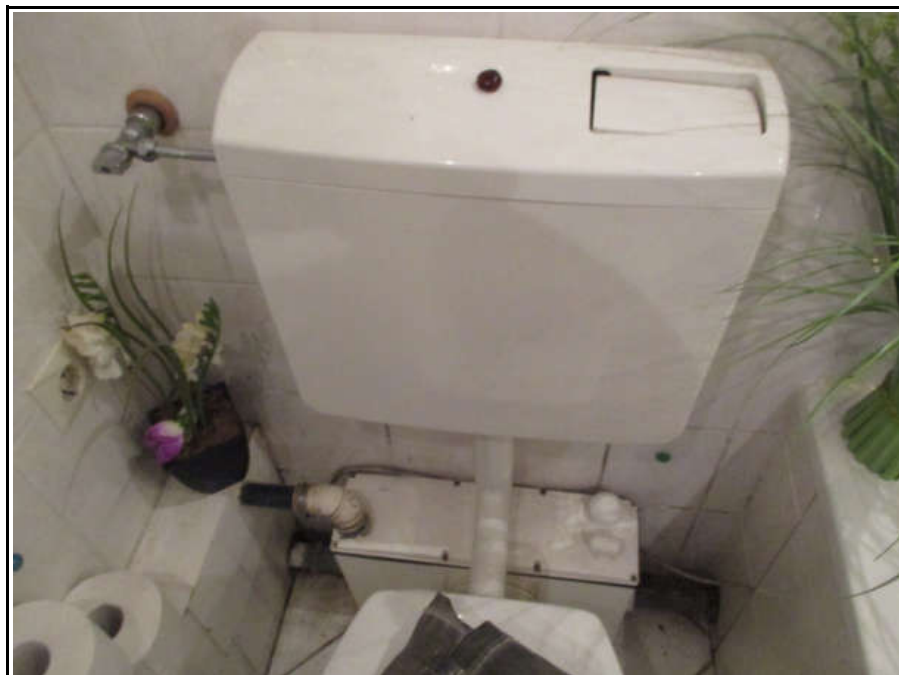
Bild 28 (Bad im KG: WC, Hebeanlage)
