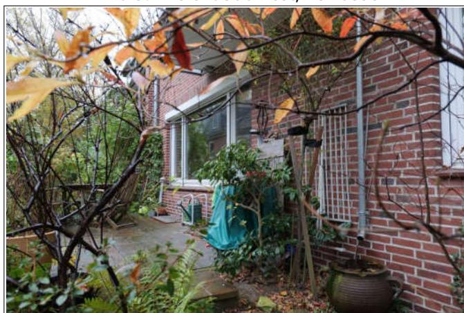
Bild 3: Ansicht Südwest, Terrasse
