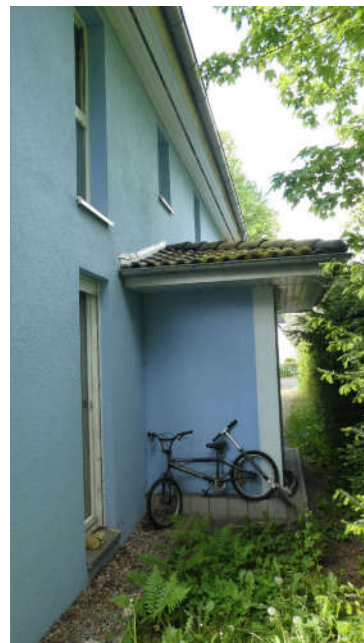
Bild 8: Teilansicht Fassade, Hauseingang rückseitig
