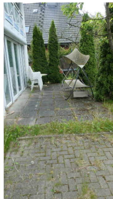
Bild 4: Bereich Terrasse, straßenseitig
