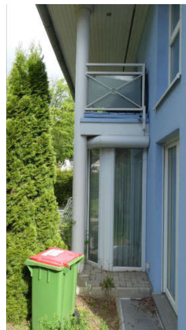
Bild 16: vorderseitiger Balkon, Erker
