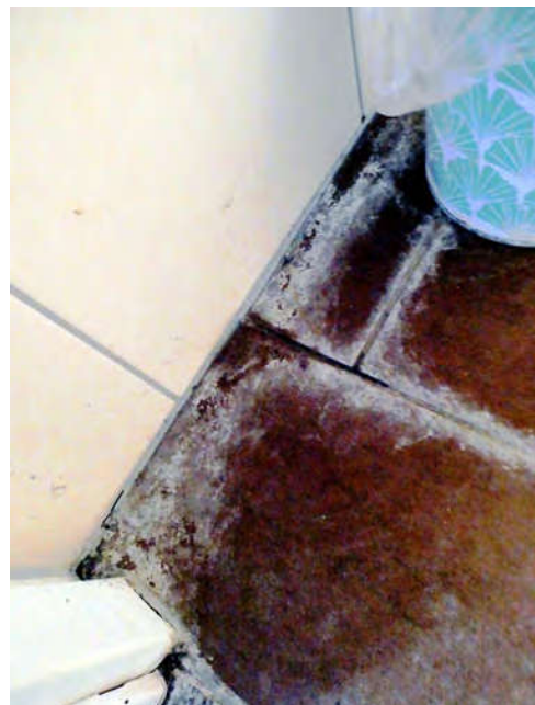
Bild 28: EG Gäste WC / Feuchtigkeitsschaden
