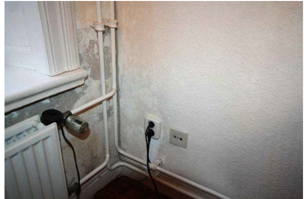
Feuchtigkeitsausblühungen im Vorderhaus in Wohnung 5 im Erdgeschoss
