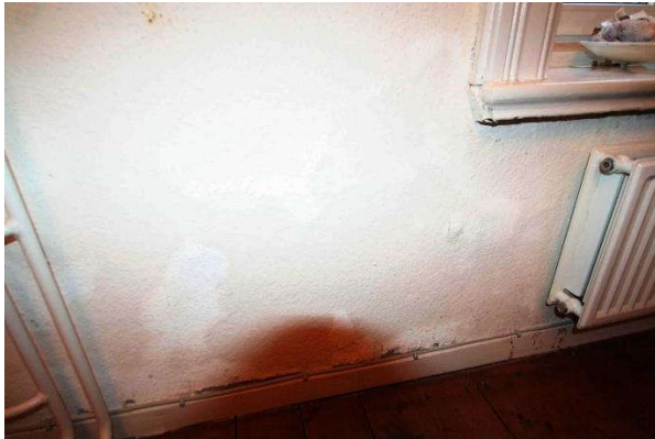
Feuchtigkeitsausblühungen im Vorderhaus in Wohnung 5 im Erdgeschoss
