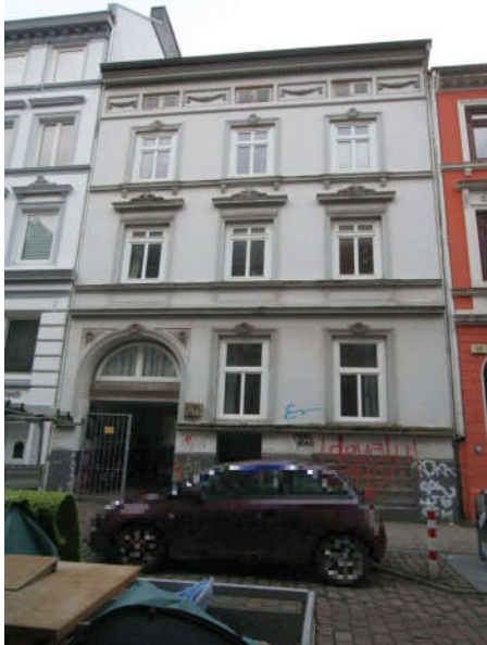
Straßenseite Vorderhaus mit Torbogen (Westen)
