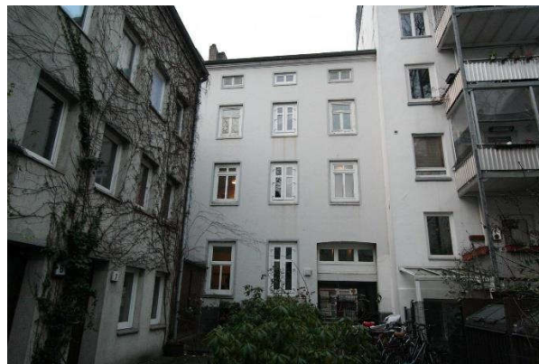
Gebäuderück- und Hofseite Vorderhaus (Osten)
