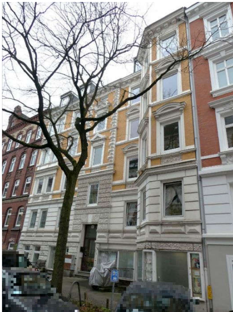
Bild 9: Ansicht von der Straße
