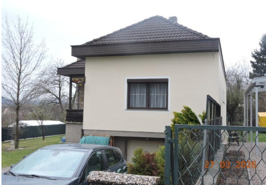
Gesamtaufnahmen des Wohngebäudes
