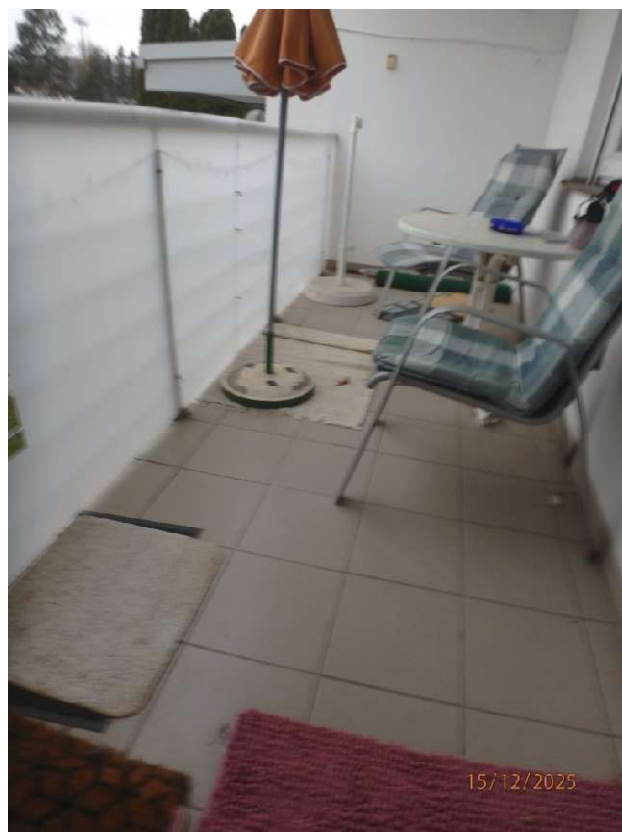
Balkon 1 / lt. NW-GA vom 29.09.2006 Loggia
