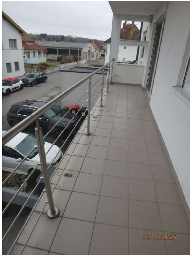
Balkon 2 / lt. NW-GA vom 29.09.2006 Loggia
