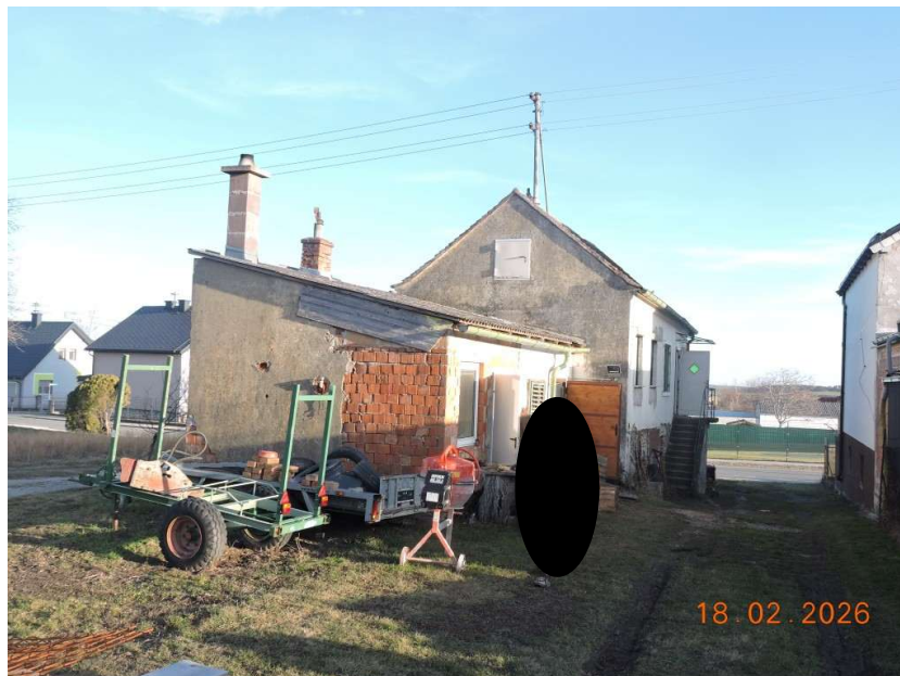
umlaufende Außenaufnahmen Nebengebäude
