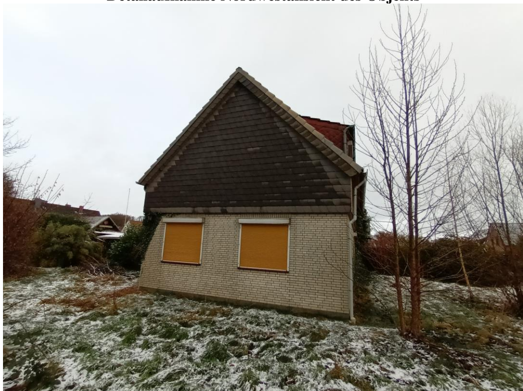
Detailaufnahme Südwestansicht des Objekts
