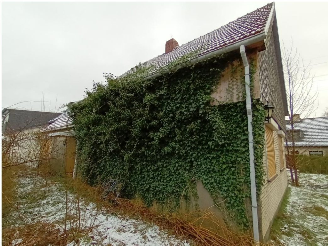
Detailaufnahme Nordwestansicht des Objekts
