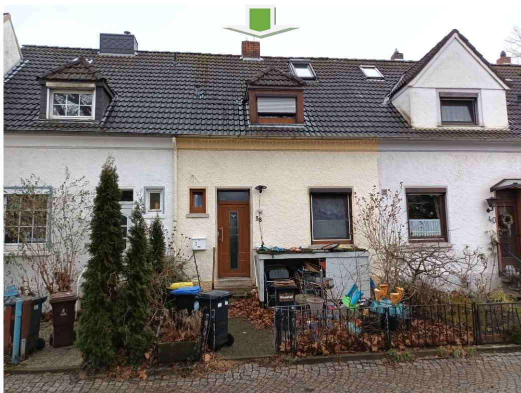
Südwestansicht des Objekts
