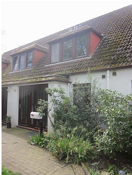
Zuwegung zu den Reihenhäusern „Senator-Bölken-Straße 2-10“
