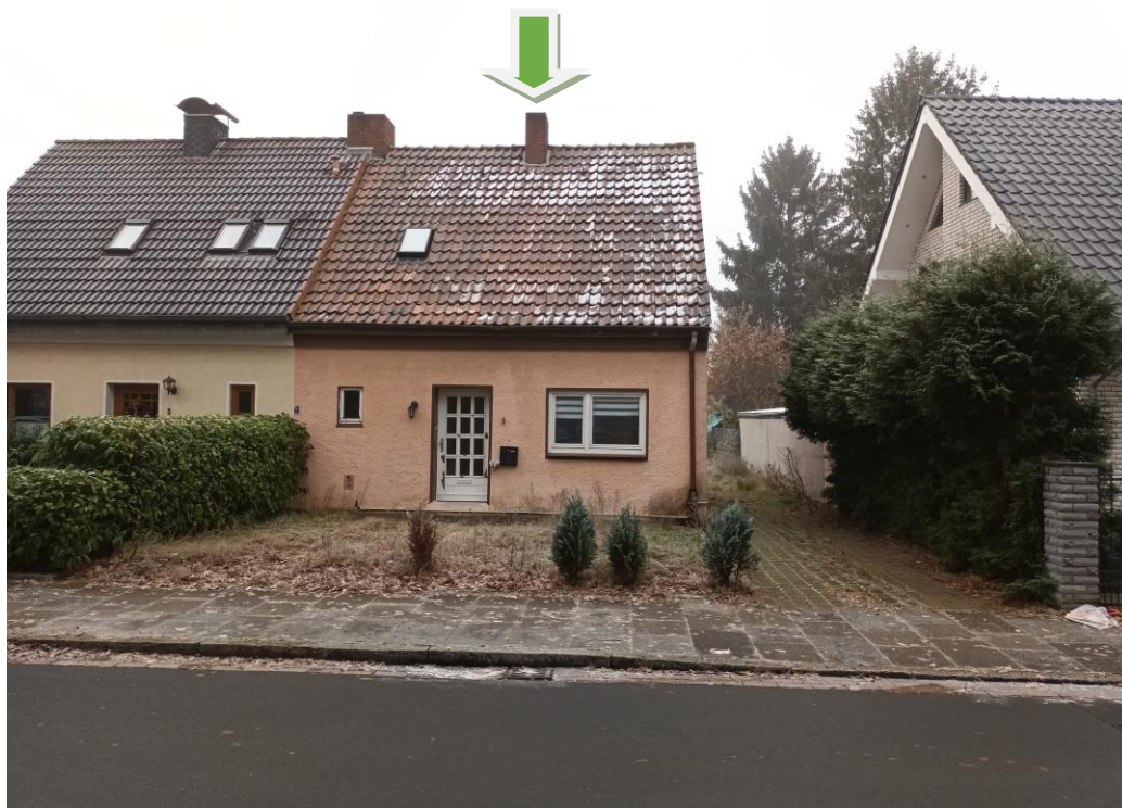
Nordansicht des Objekts, Doppelhaushälfte rechts im Bild
