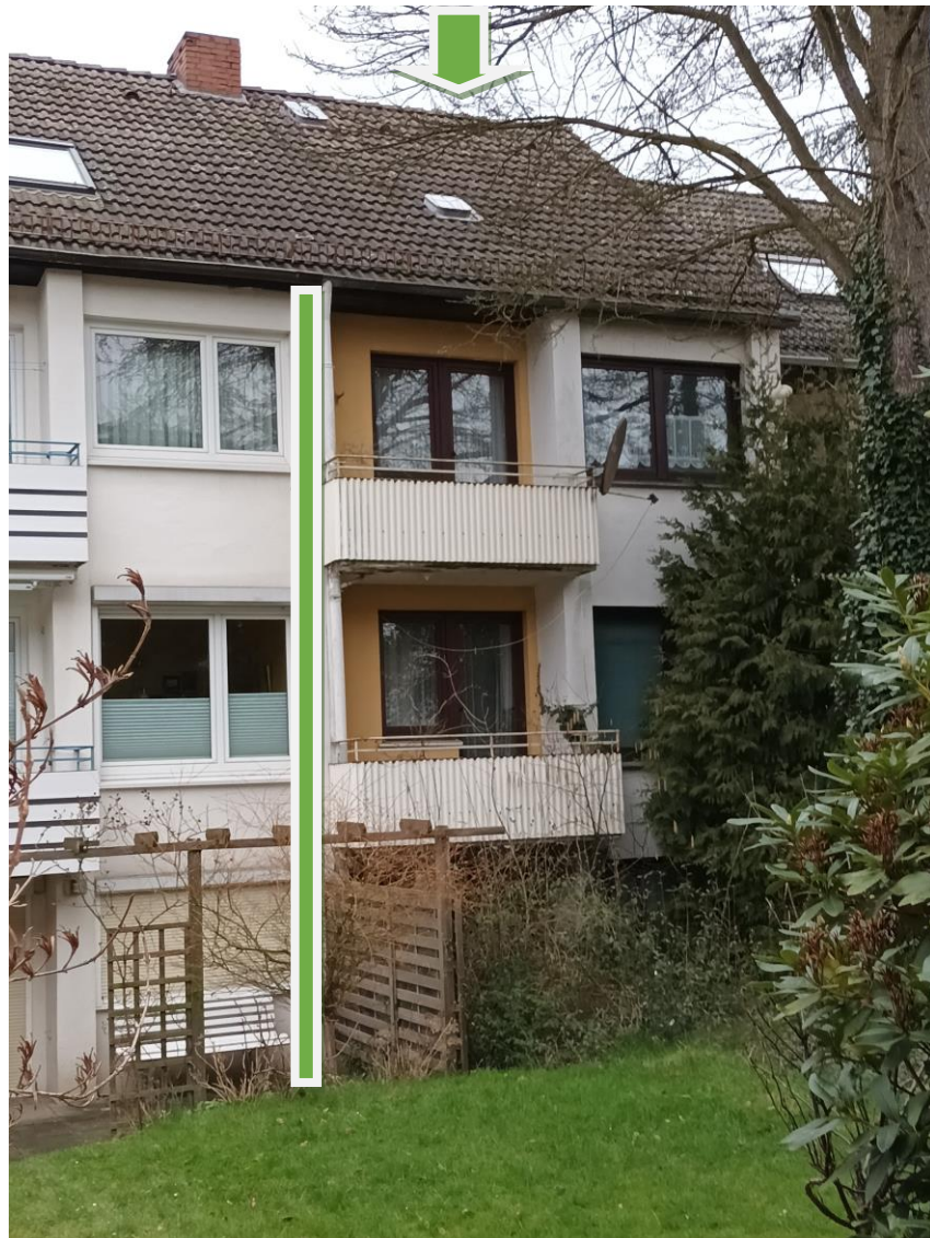
Südwestansicht des Objekts
