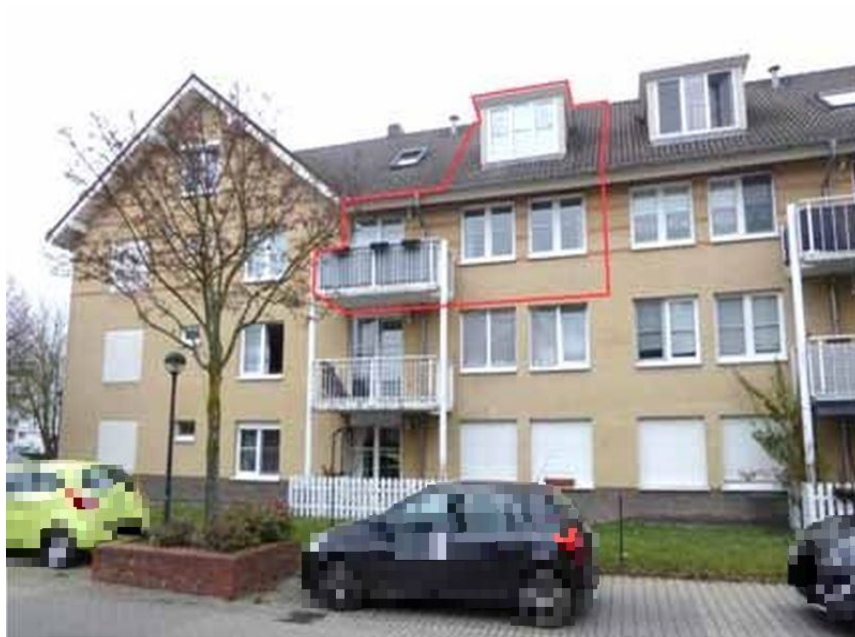
Bild 2: Straßenansicht Attilastrasse 31-37 mit Kennzeichnung WE Nr. 21
