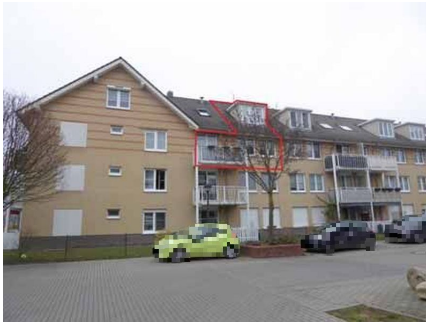
Bild 1: Straßenansicht Attilastrasse 31-37 mit Kennzeichnung WE Nr. 21
