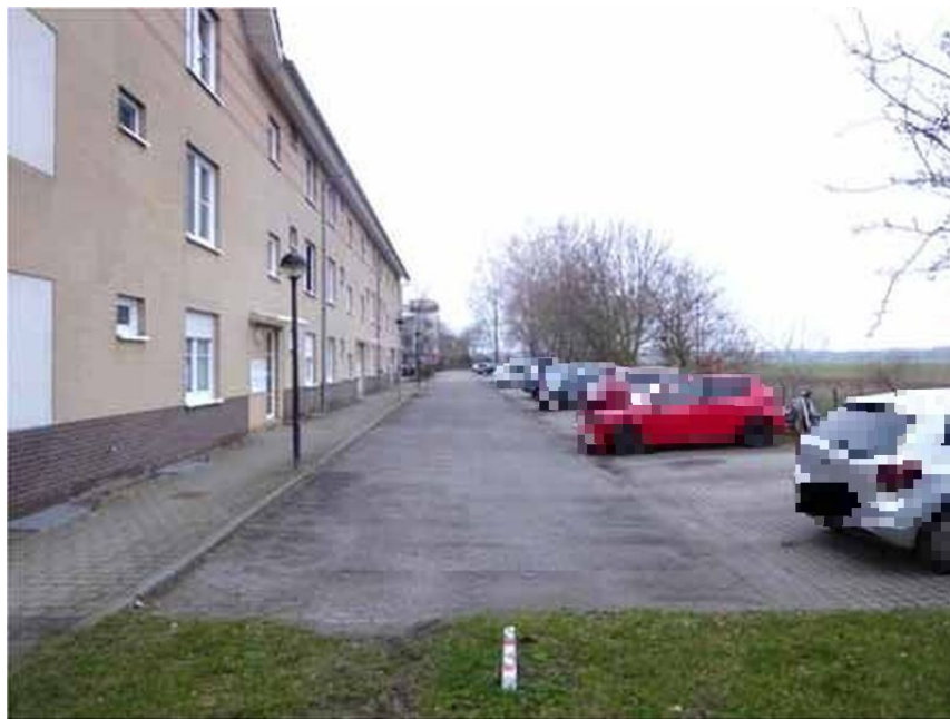
Bild 9: Rückansicht Attilastrasse 39-45 mit Stellplatz-/Verkehrsfläche
