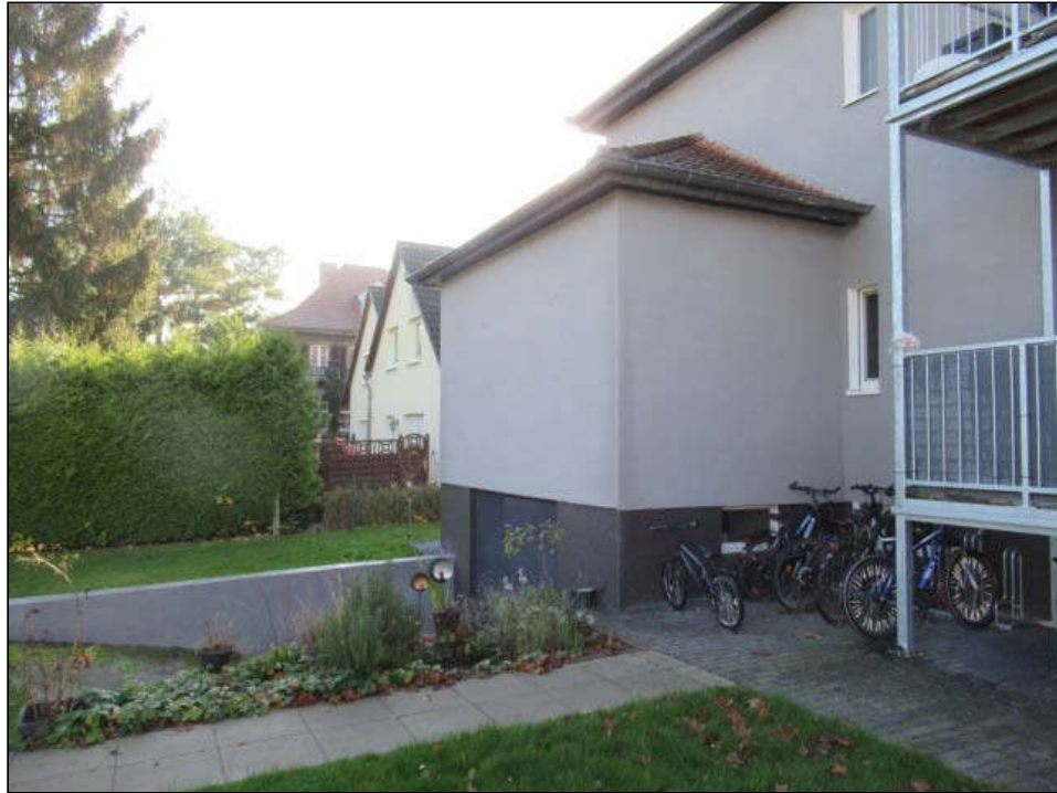
Rückansicht mit Anbau
