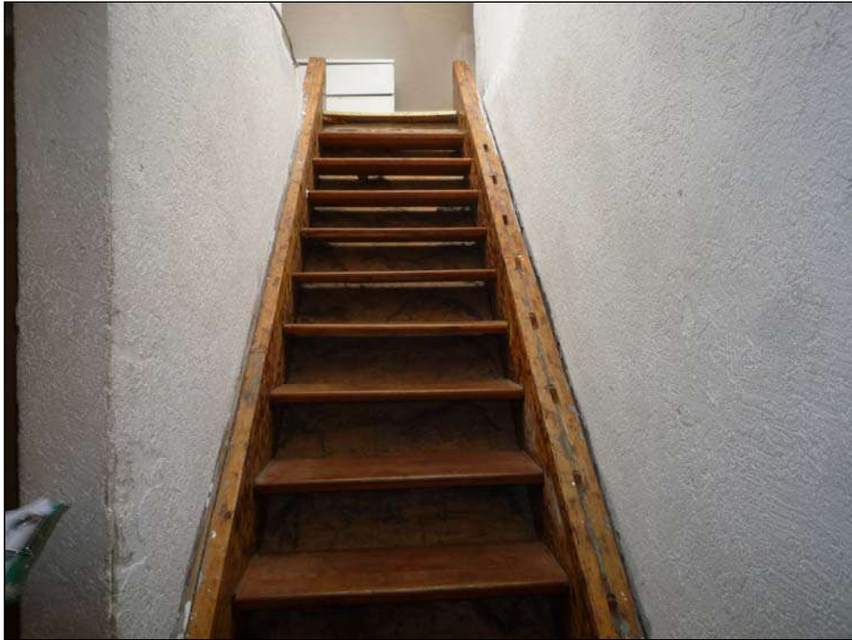
Treppe zum Dachgeschoss
