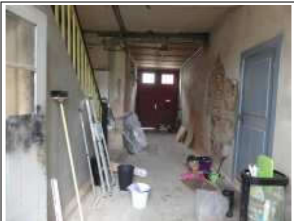
Hausflur/Durchfahrt zur Straße
