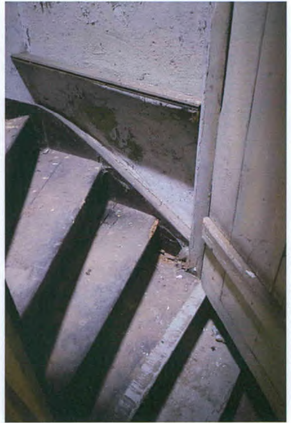
Einfache Treppenführung zum Dachgeschoss (Tierfraß)
