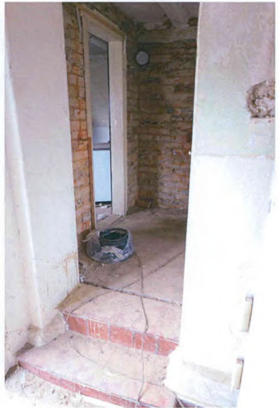
Zugang zu den Wohnräumen
