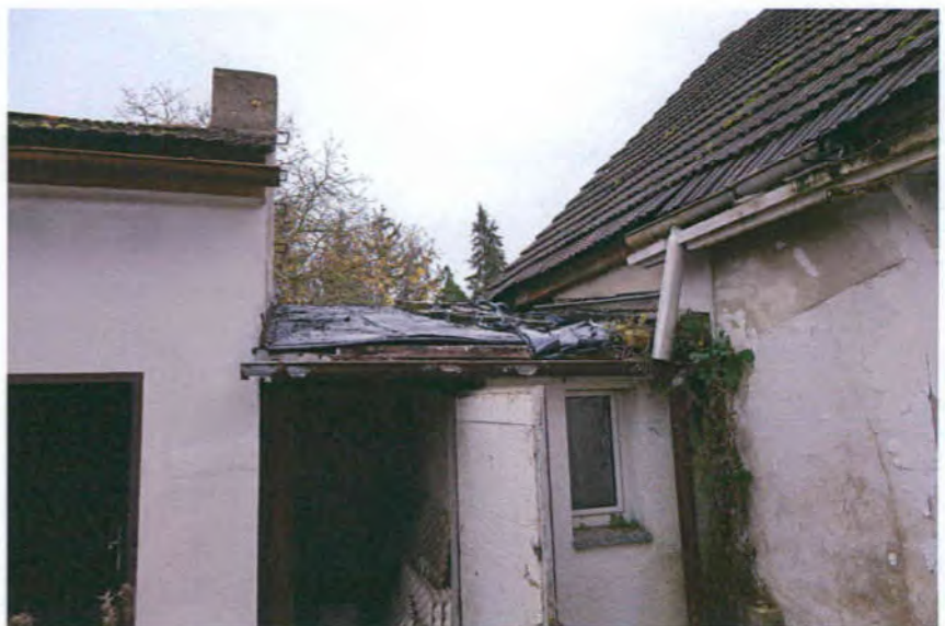
Desolate Dacheindeckung
