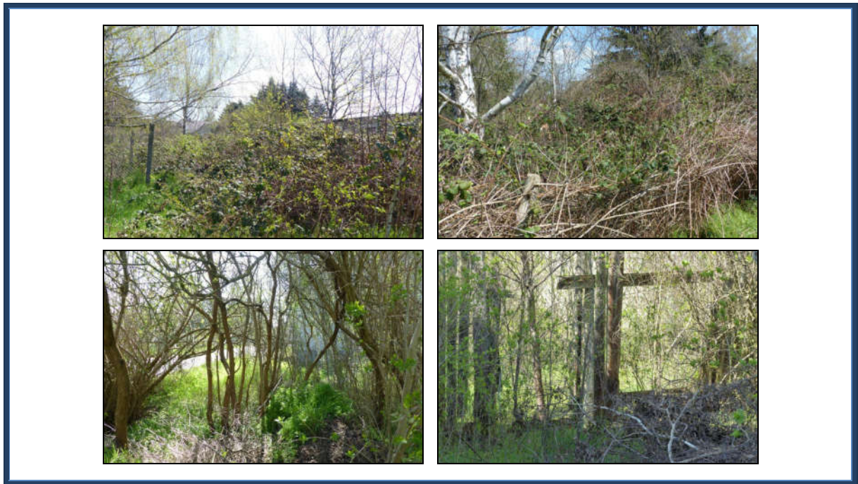
Abbildung 9: Detailansichten der stark verwilderten Außenanlagen (Bewertungsteilbereich I)
