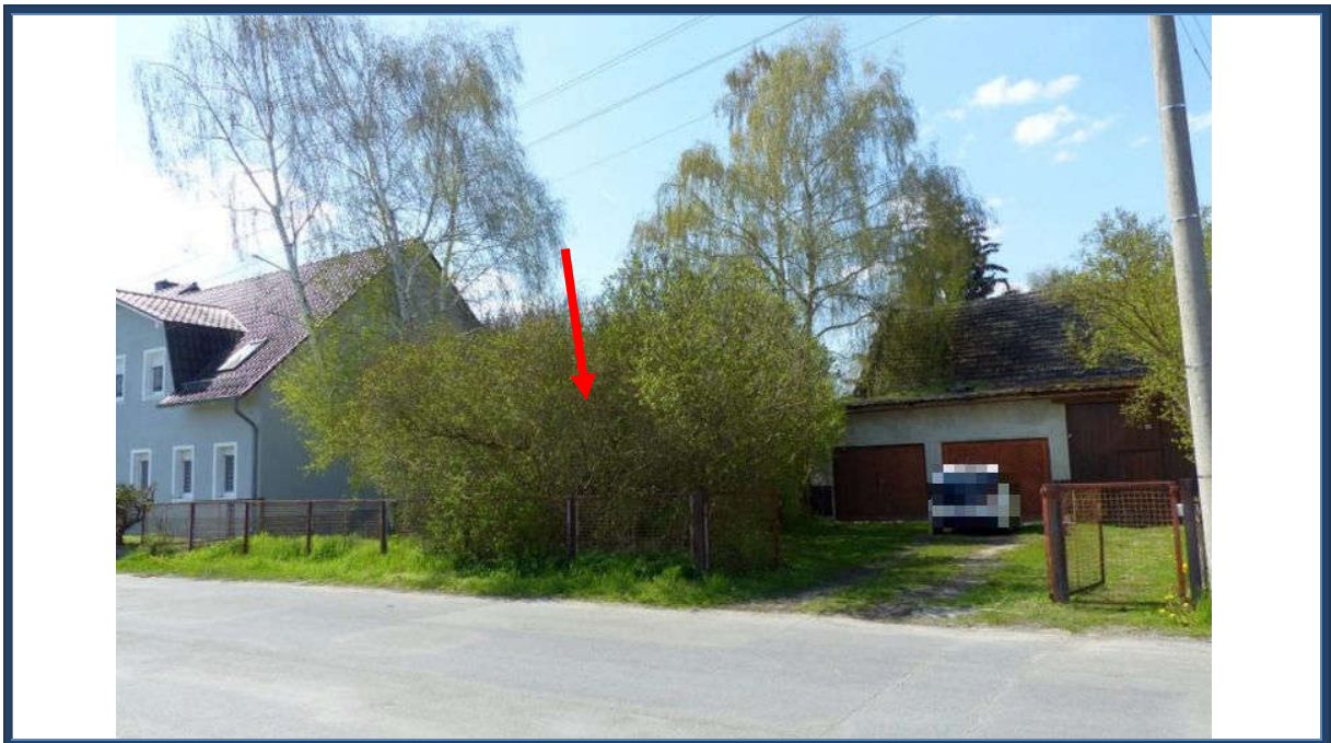
Abbildung 2: Blick von der Tiergartenstraße in nordwestliche Richtung (Bewertungsteilbereich I); stark verwilderte Außenanlagen; angrenzende Bebauung
