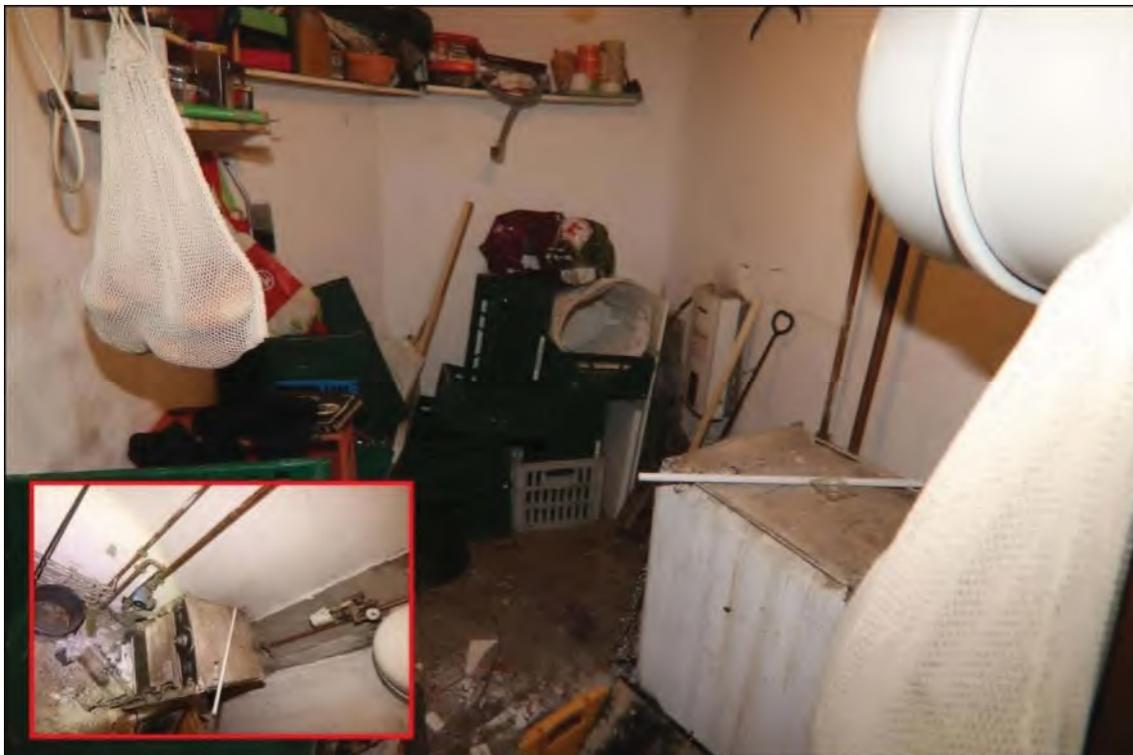
Blick vom Flur in den Heizungsraum im Erdgeschoss. Hier gibt es noch eine alte Schwerkraftheizung, die auch im Bildausschnitt zu erkennen ist. Hier soll es allerhand technische Defizite geben, so dass sie nicht mehr sachgerecht betrieben werden kann. Im Hintergrund der elektrische Durchlauferhitzer, der vermutlich für die Warmwasserversorgung genutzt wurde.
