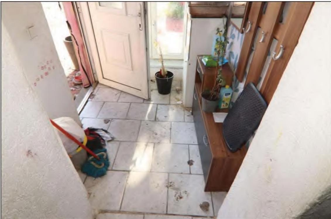
Blick vom Flur in den gefliesten Eingangsvorbau. Geradeaus gibt es ein nahezu bodengleiches Fenster. Links sieht man die moderne Eingangstür aus Kunststoff. Der im Vordergrund erkennbare Durchgang ist die ursprüngliche Eingangsöffnung. Der Gebäudevorbau mit dem Windfang wurde vermutlich später angebaut.
