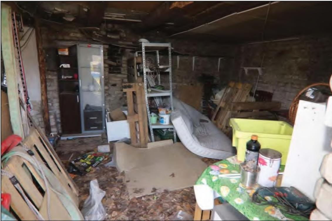
Blick in einen weiteren Abstellraum, der im mittleren Bereich vom Nebengebäude liegt. Hier kann man gut in Richtung Decke die zum Teil geschädigten Holzbalken erkennen. An den Wänden ist das Mauerwerk überwiegend in Kalksandstein gut zu sehen. Links wurde ein Durchbruch zum angrenzenden Abstellraum geschaffen.
