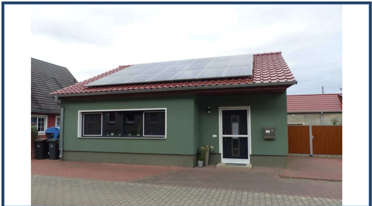
Abbildung 8: Straßenansicht (Ost-Ansicht) des Bürogebäudes [B]; rechts der Haupteingangsbereich; Außenanlagen; umliegende Bebauung
