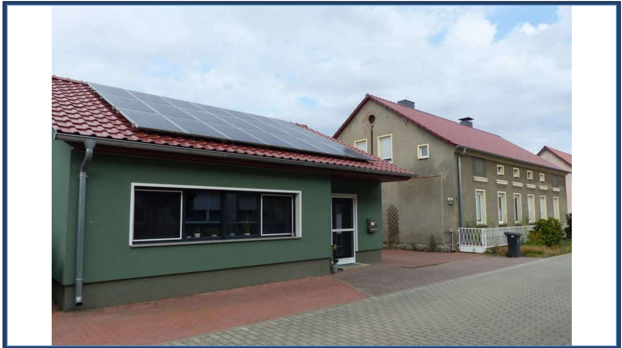
Abbildung 11: Blick in nordöstliche Richtung; links das Bürogebäude [B]; rechts das Wohngebäude [A]
