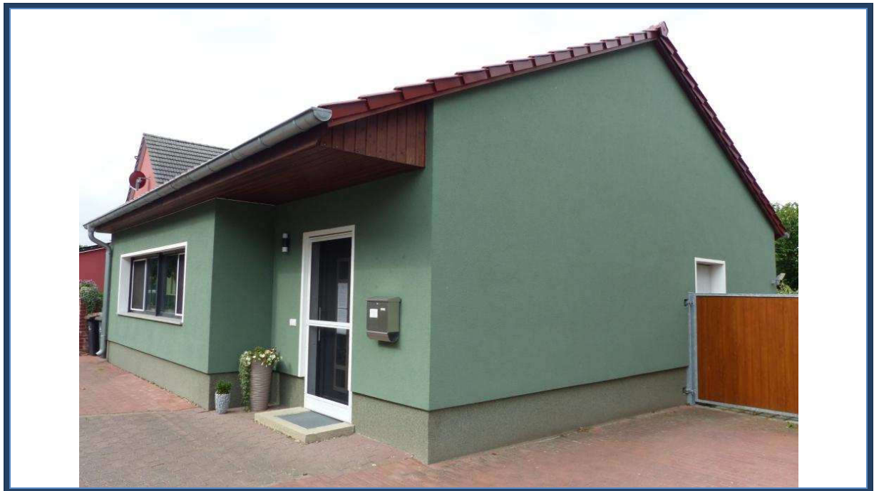
Abbildung 7: Straßen- und Giebelansicht (Nord-Ost-Ansicht) des Bürogebäudes [B]; rechts der Haupteingangsbereich; Außenanlagen
