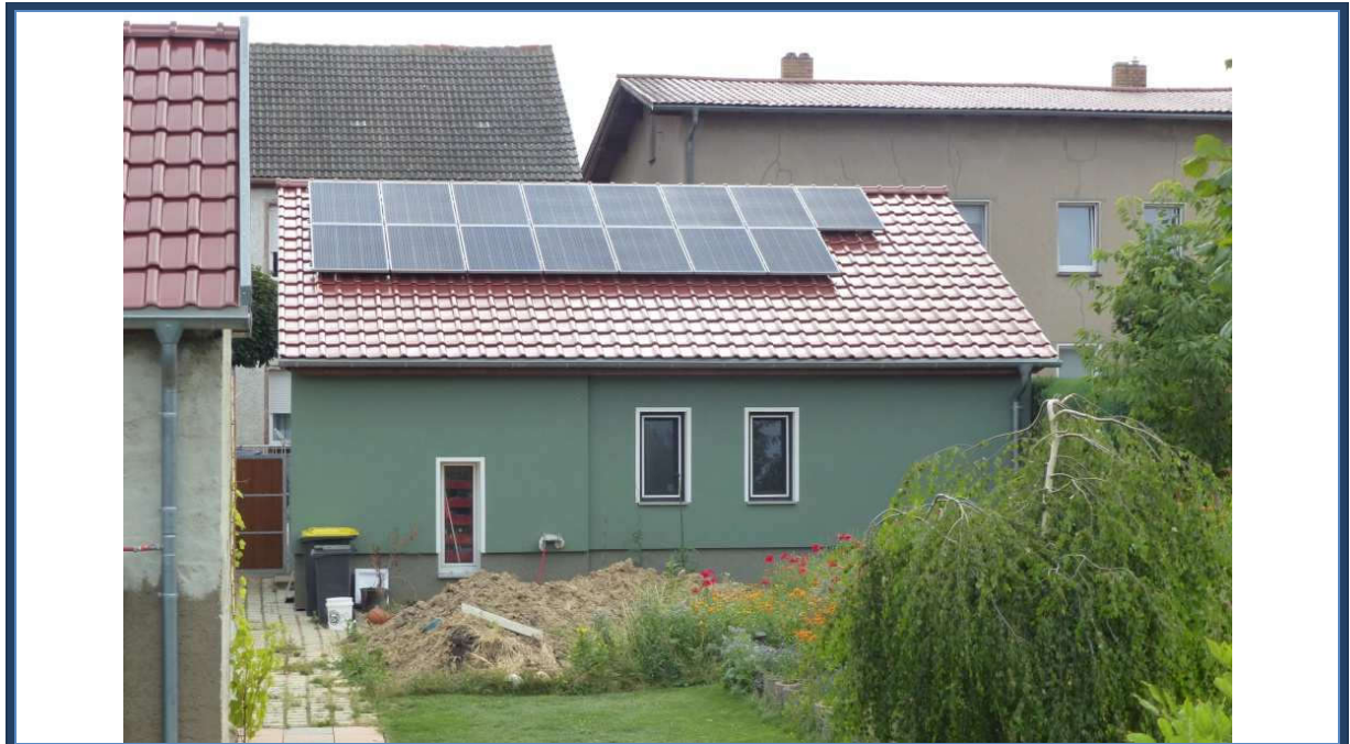
Abbildung 18: Blick in östliche Richtung; Rückansicht des Bürogebäudes [B]; Außenanlagen; umliegende Bebauung
