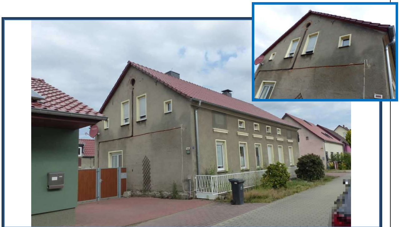
Abbildung 4: Straßen- und Giebelansicht des Wohnhauses [A] (Süd-Ost-Ansicht); Außenanlagen; mittig der Haupteingangs- und Einfahrtsbereich; links das Bürogebäude [B]; umliegende Bebauung
