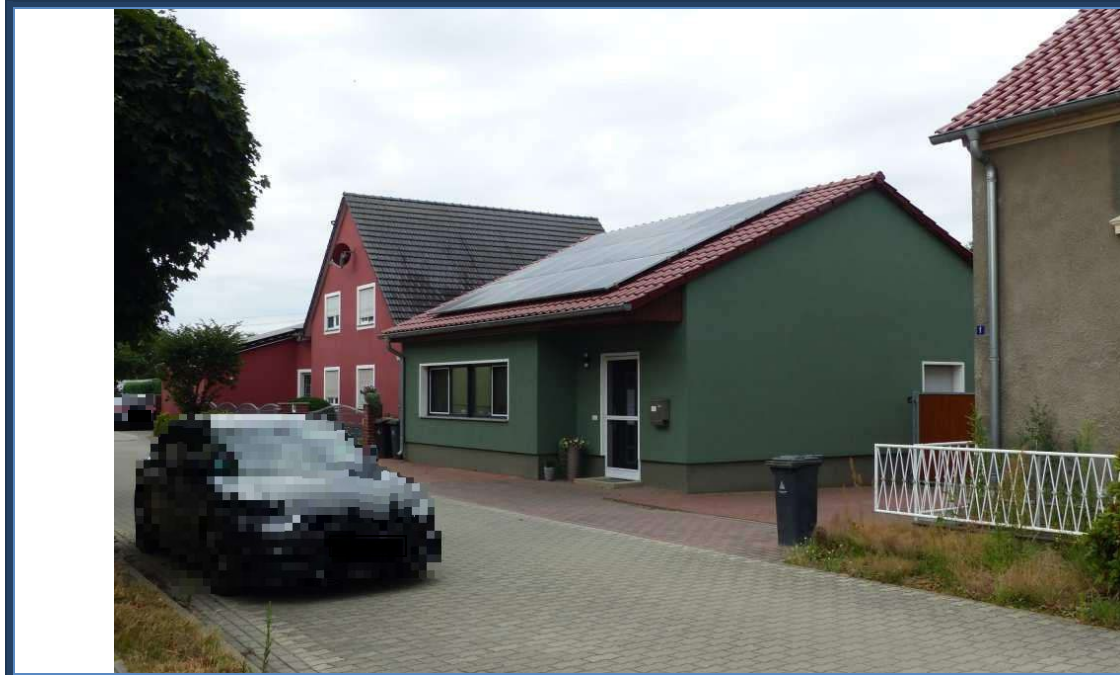
Abbildung 9: Straßen- und Giebelansicht (Nord-Ost-Ansicht) des Bürogebäudes [B]; rechts das Wohngebäude [A]; umliegende Bebauung
