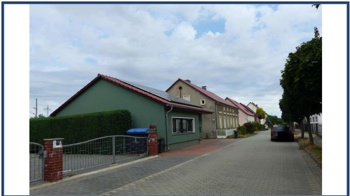
Abbildung 12: Blick in nördliche Richtung in die Eisenbahner Straße; links das Bewertungsobjekt; umliegende Bebauung
