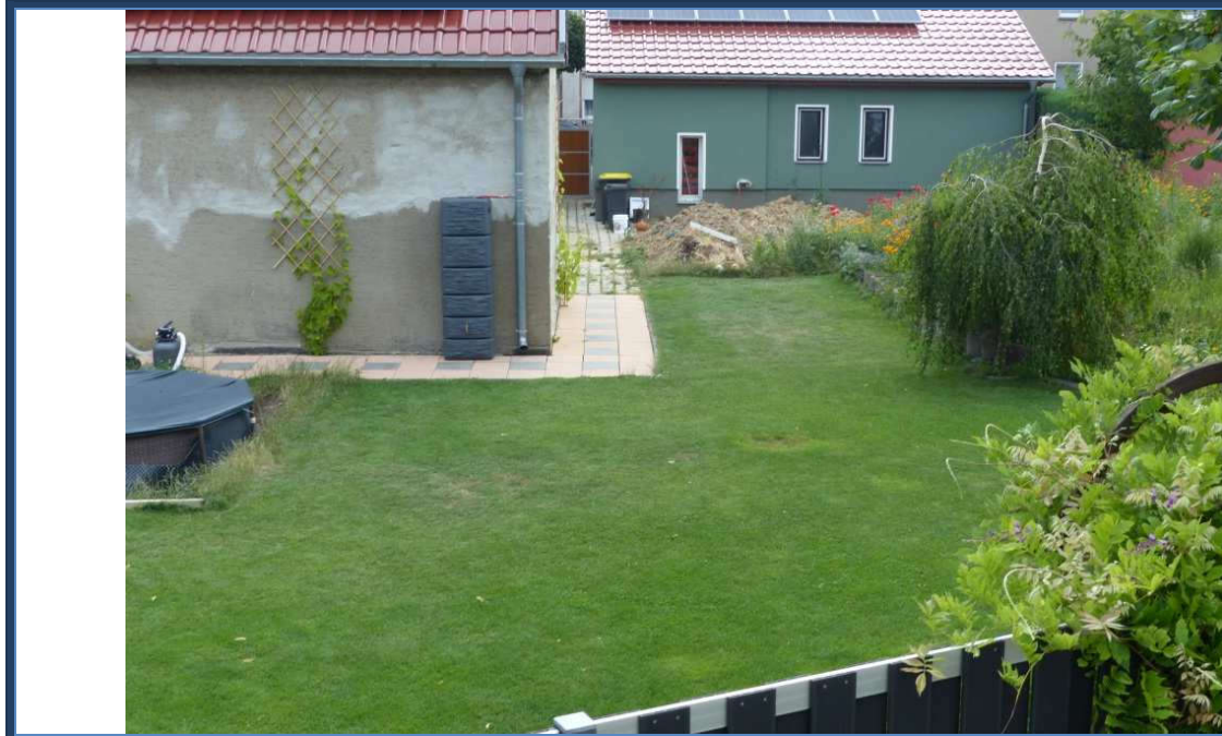
Abbildung 17: Blick in östliche Richtung; rückseitiger Bereich der zu bewertenden Grundstücke; links das Mehrzweckgebäude [C]; rechts das Bürogebäude [B]; Außenanlagen
