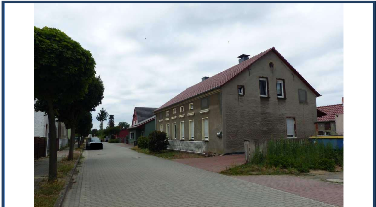
Abbildung 10: Blick in südliche Richtung in die Eisenbahner Straße; rechts das Bewertungsobjekt; umliegende Bebauung
