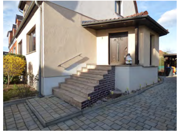
Foto2: Eingangsbereich mit Anbau
