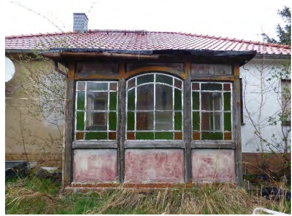
Foto2: Hofansicht Wohnhaus mit Anbau
