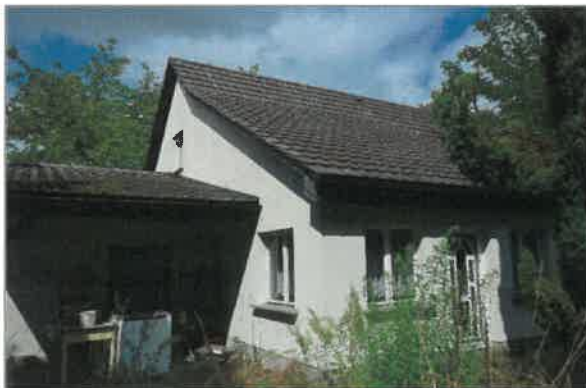
Seitliche Ansichten- von Osten
