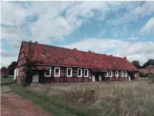
Abbildung: Ansicht von der Straße Dorfstraße Krampfer (Ostseite)
