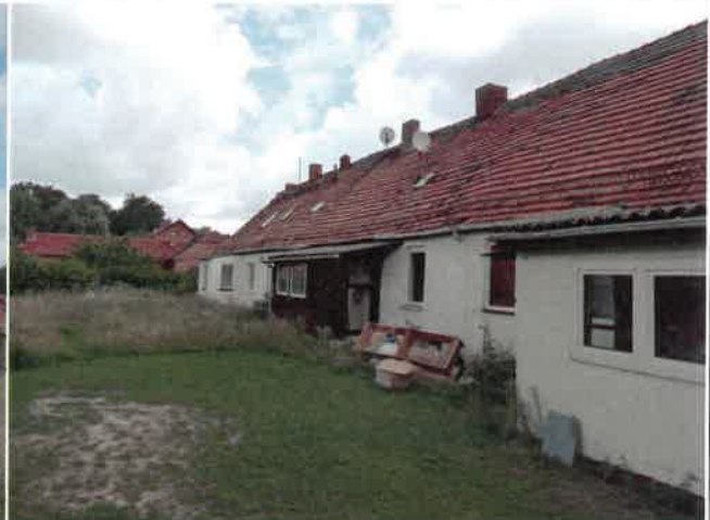
Abbildung: Ansicht von der Westseite (Detail)
