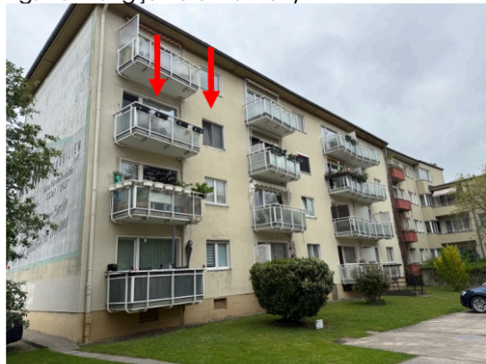
Rückansicht des Gebäudes (Bewertungswohnung jeweils markiert)
