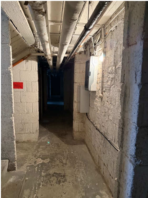
Flurbereich im Keller
