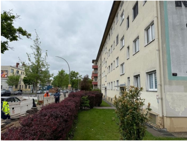
Fassade und Grundstück vor dem Gebäude
