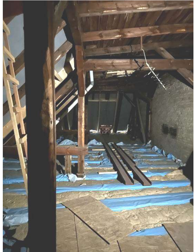
Dachrohlung Gartenhaus Teileigentum #19
