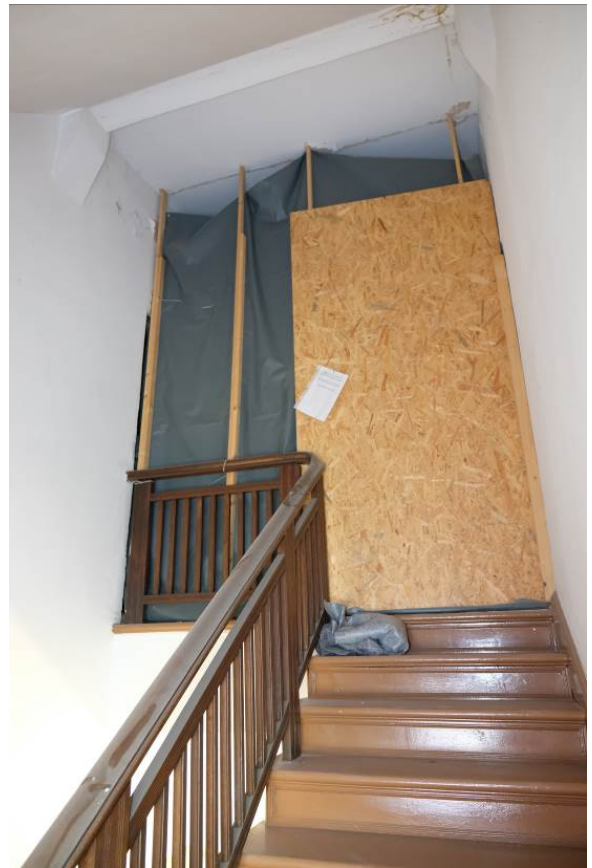
Treppenpodest zum Dachgeschoss Seitenflügel
