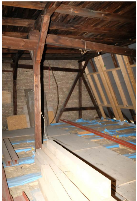
Teileigentum #18 Dachgeschoss rechts
