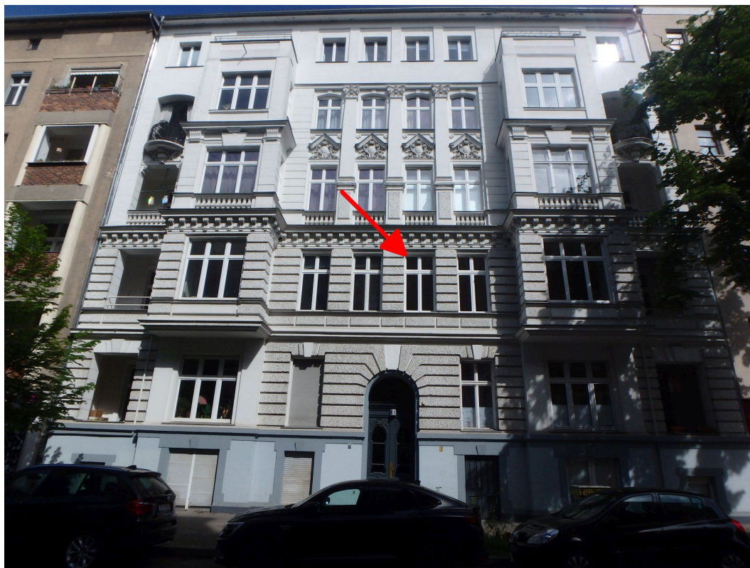
Mehrfamilienwohnhaus Südansicht (Straßenansicht)
