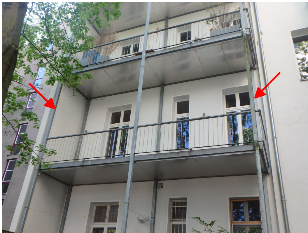
Mehrfamilienwohnhaus sowie Eigentumseinheit Nr. 5 Nordwestansicht
