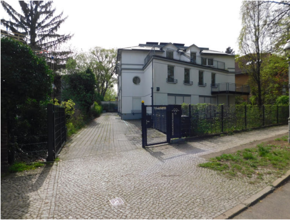
Brauerstraße 15 in 12209 Berlin-Lichterfelde - straßenseitige Gebäudeansicht und TE Nr. 9 im Erdgeschoss / Untergeschoss -
