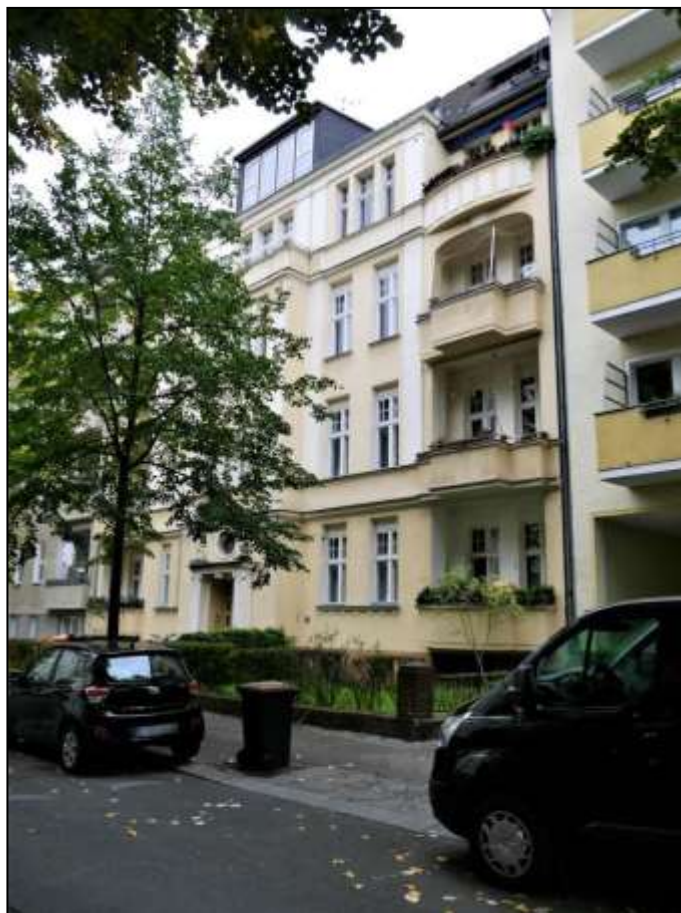
straßenseitige Front des auf dem Grundstück Liliencronstraße 13 aufstehenden Mietwohnhauses
