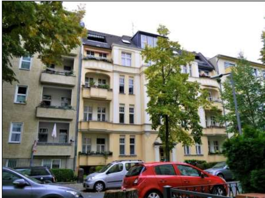
straßenseitige Front des auf dem Grundstück Liliencronstraße 13 aufstehenden Mietwohnhauses
