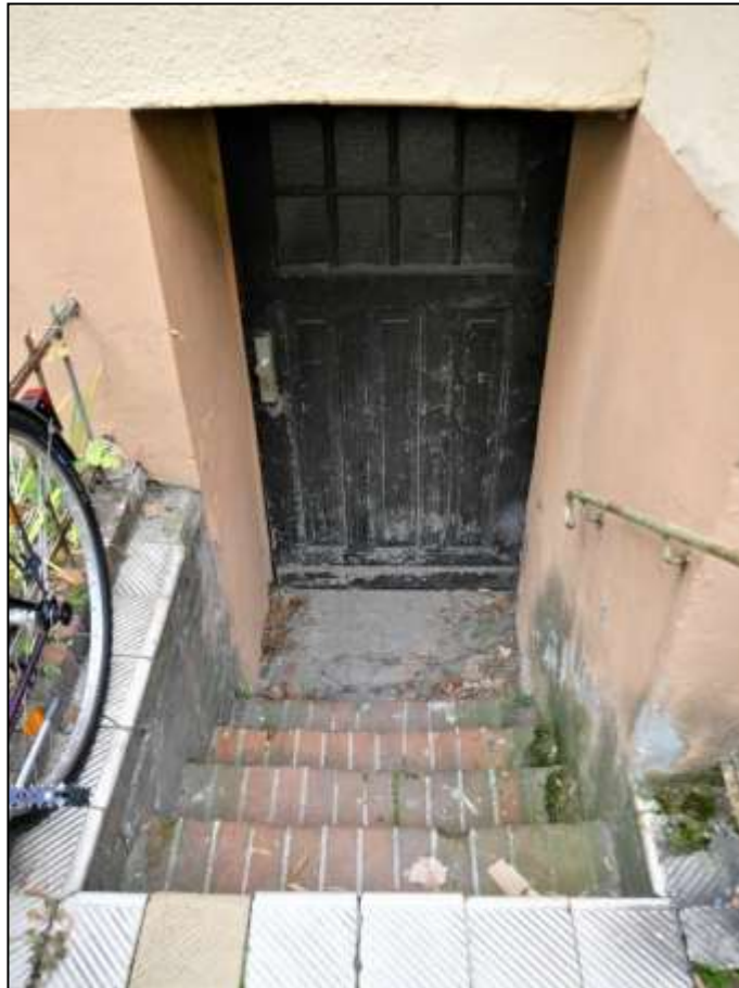
Kelleraußen- treppe mit Kell- erzugang aus dem Vorgarten- bereich
