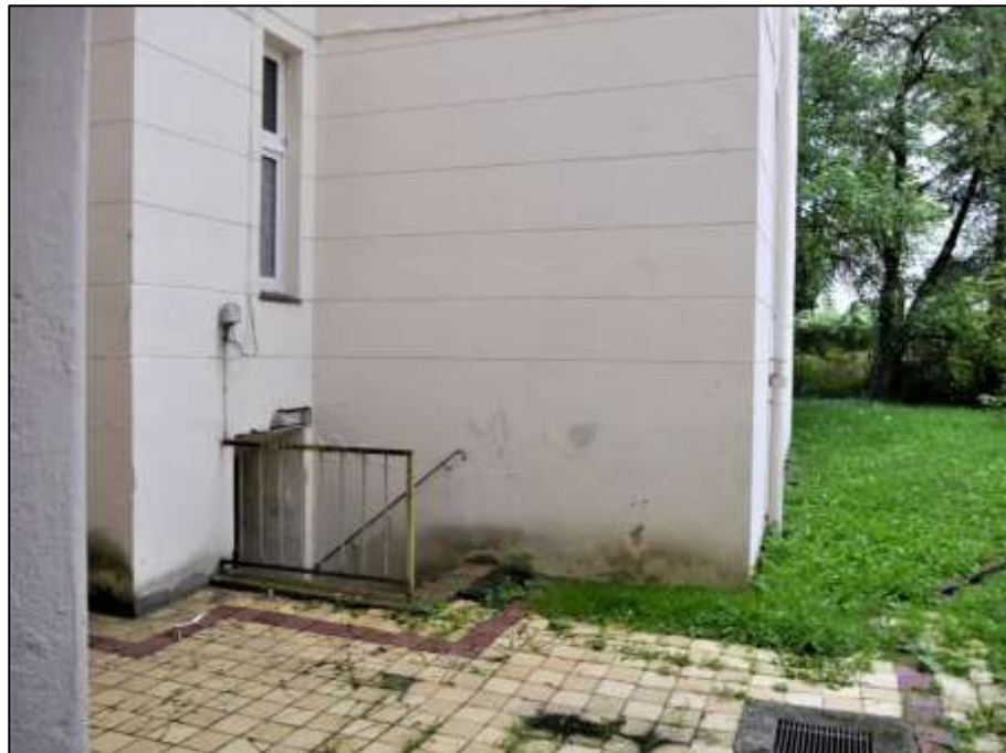
Kelleraußentreppe zum Seitenflügelkeller
