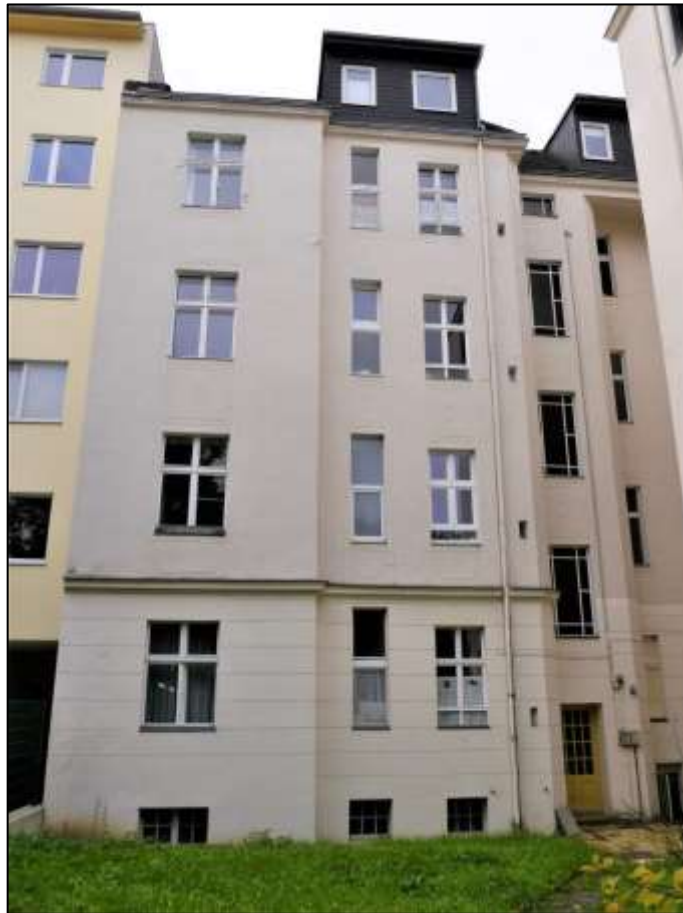
rückwärtige Front des Vorderhauses auf dem Grundstück Liliencronstr. 13
