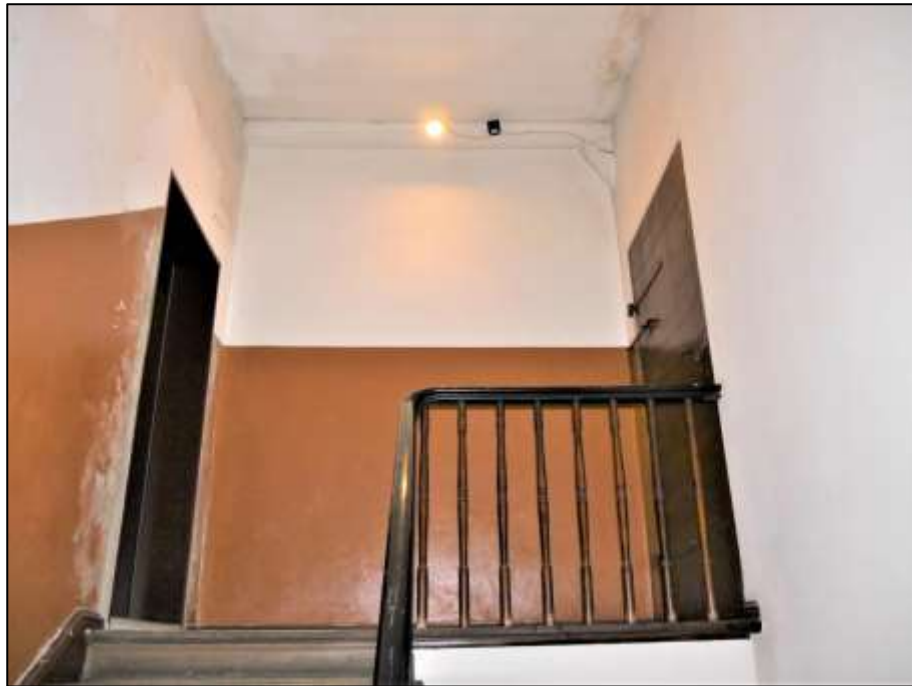
Treppenhauskopf im Seitenflügel
