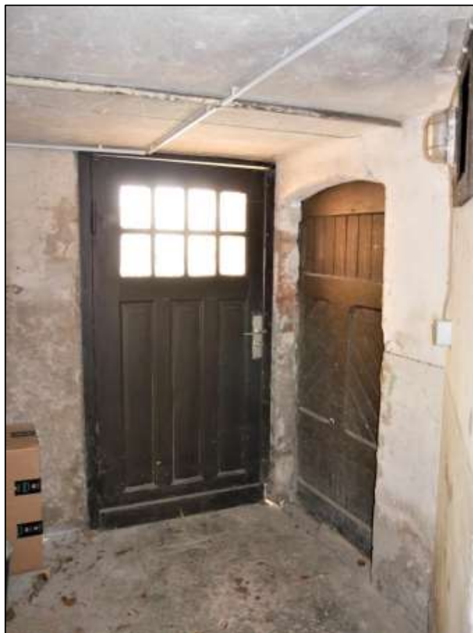
Außentür zur Kelleraußentreppe aus dem Vorgartenbereich in den Gebäudedurchgang im Kellergeschoss des Vorderhauses
