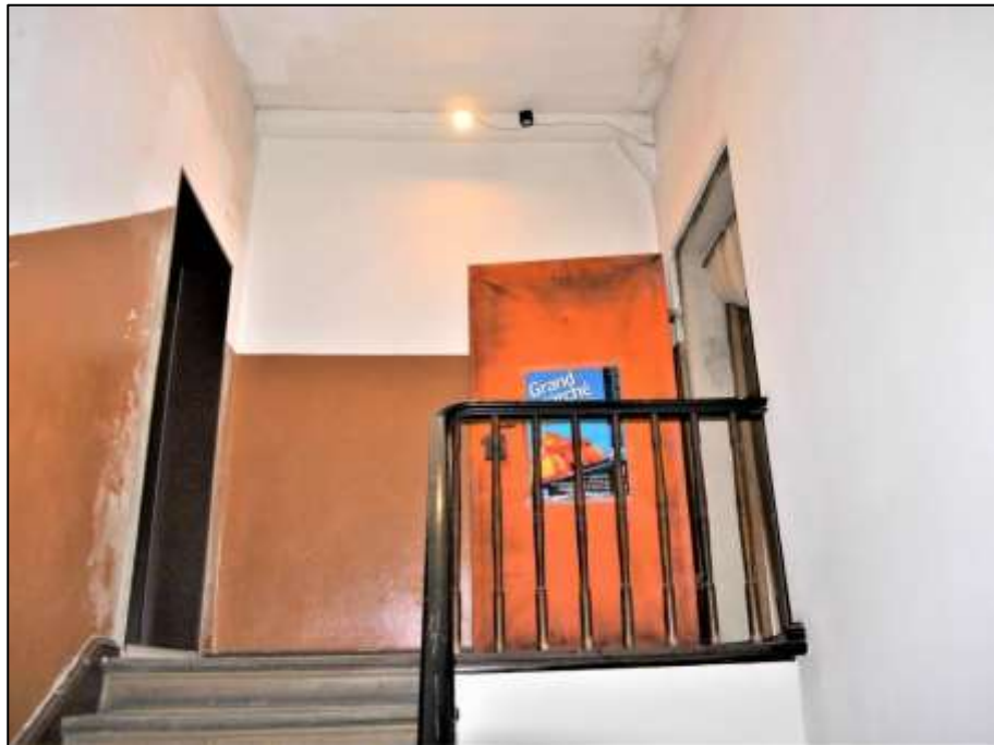
Treppenhauskopf im Seitenflügel mit postalisch rechts anbindendem Rohdachboden im Seitenflügel
