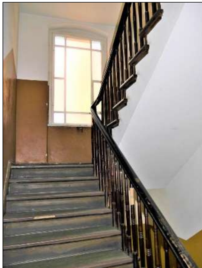
aufgehendes Treppenhaus im Seitenflügel
