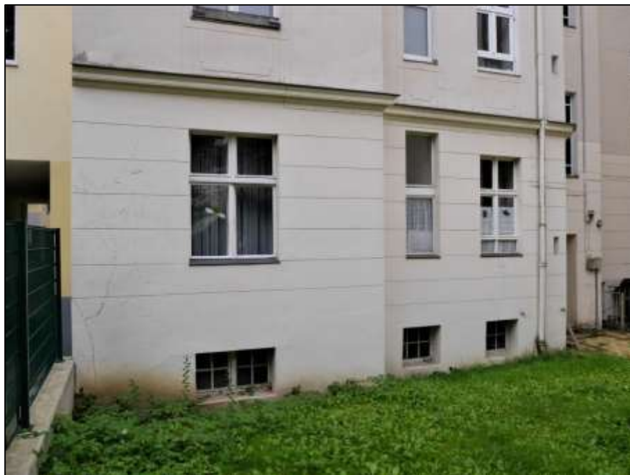
rückwärtige Front des Vorderhauses im Bereich des Hochparterres mit über Terrain aufgehenden Kellerfenstern
