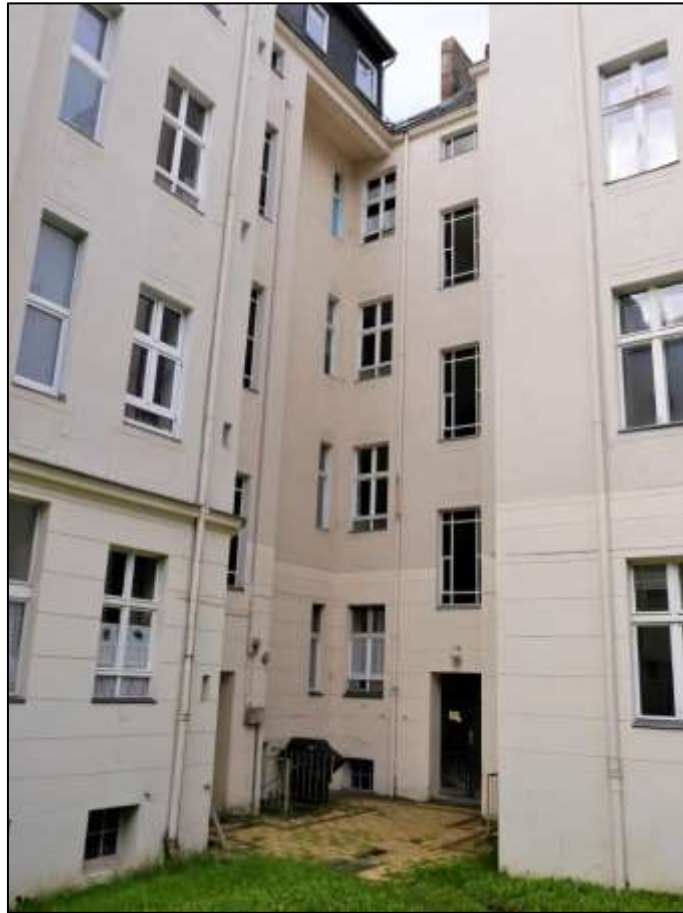
rückwärtige Front des Vorderhauses im Zwickel zwischen Vorderhaus und anbindendem Seitenflügel
