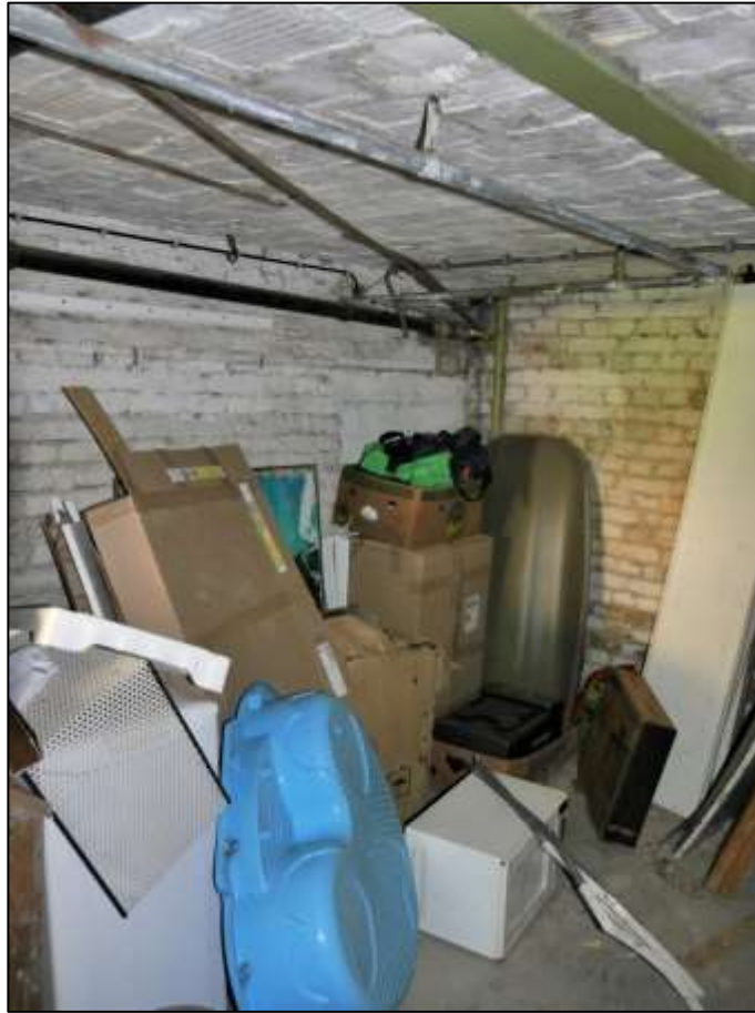
offener Bereich im Kellergang im Seitenflügel
