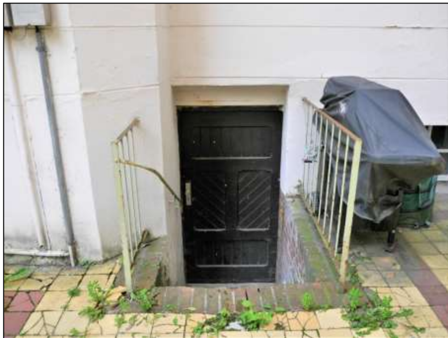
Kelleraußentreppe zum Vorderhauskeller
