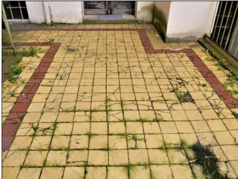
Zuwegungsbereich vor den Hauseingängen von Vorderhaus und Seitenflügel und den hofseitigen Kelleraußentritten mit Treppenhauszugang des Seitenflügels im Hintergrund
