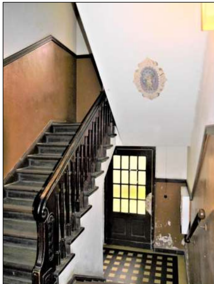
Hauseingangs- bereich des Vorderhauses mit hofseitigem Ausgang und aufgehendem Treppenhaus
