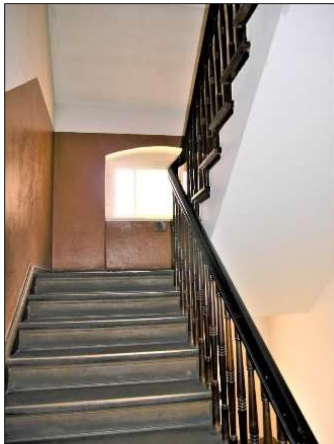
aufgehendes Treppenhaus im Seitenflügel
