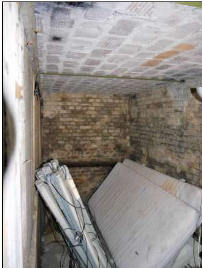
offener Bereich im Kellergang im Seitenflügel
