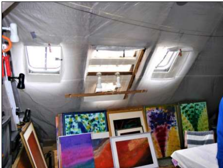
als Maler-Atelier genutzter Rohdachboden im Seitenflügel
