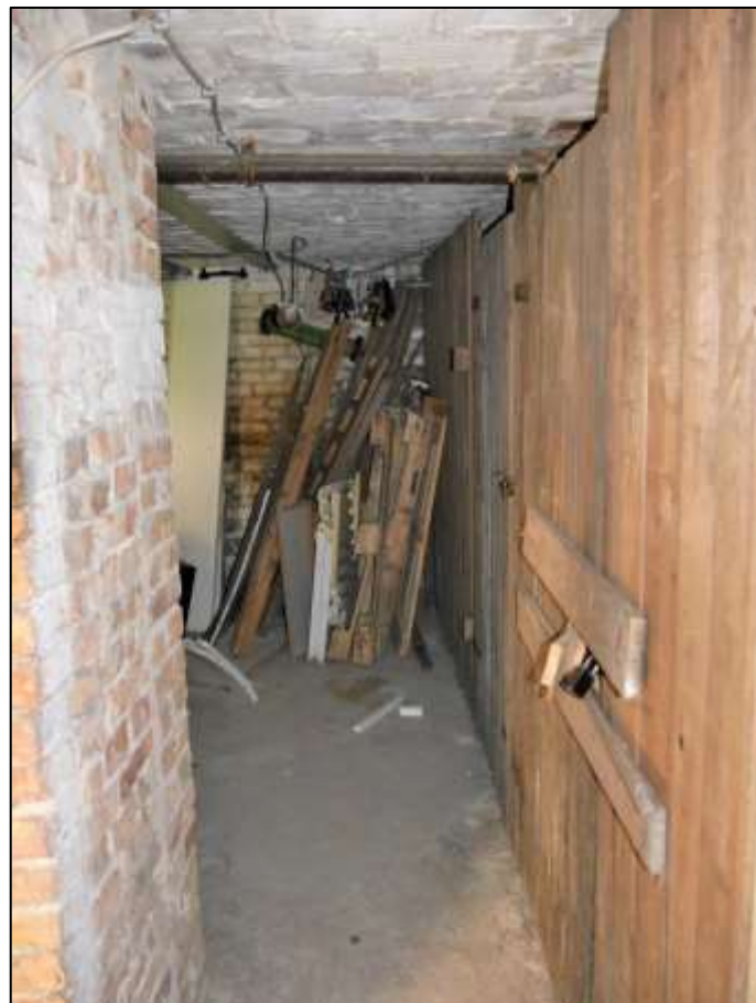
Kellergang im Seitenflügel mit Abstellverschlä- gen
