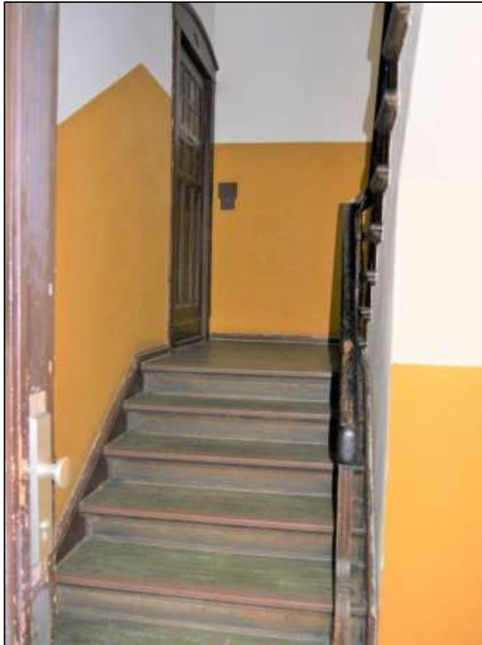
Hauseingangs- bereich des Treppenhauses im Seitenflügel
