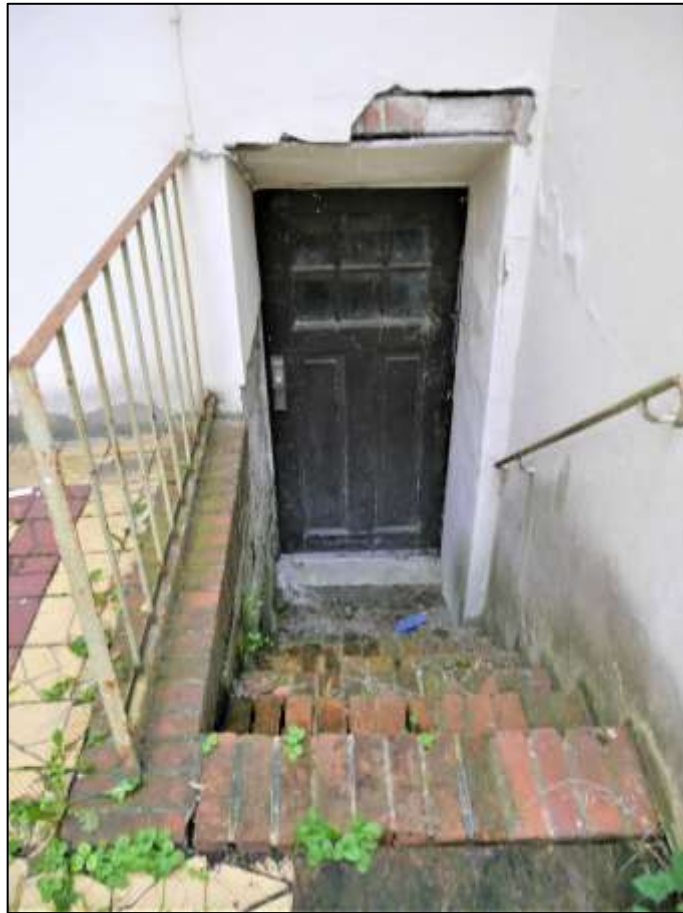
Kelleraußen- treppe zum Sei- tenflügelkeller
