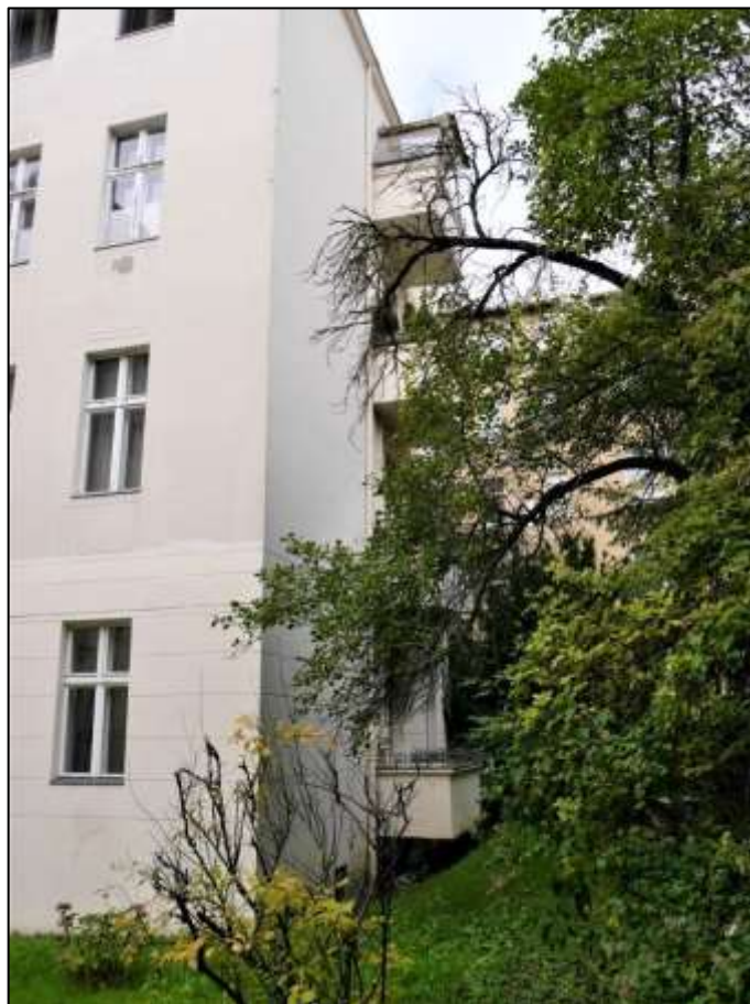
nord-östliche Kopfseite des Seitenflügels auf dem Grundstück Liliencronstr. 13
