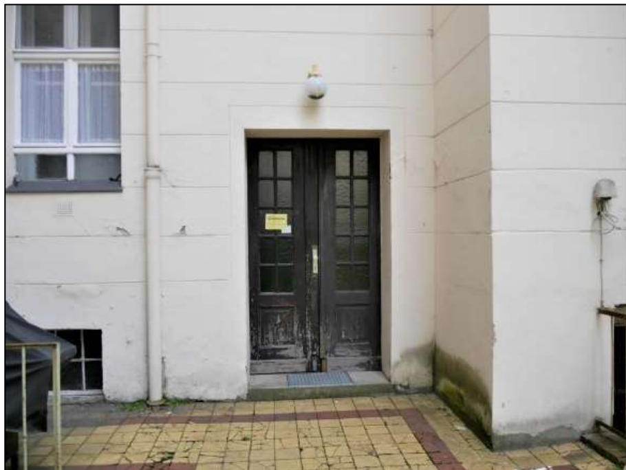
Hauseingang des Seitenflügel-Treppenhauses
