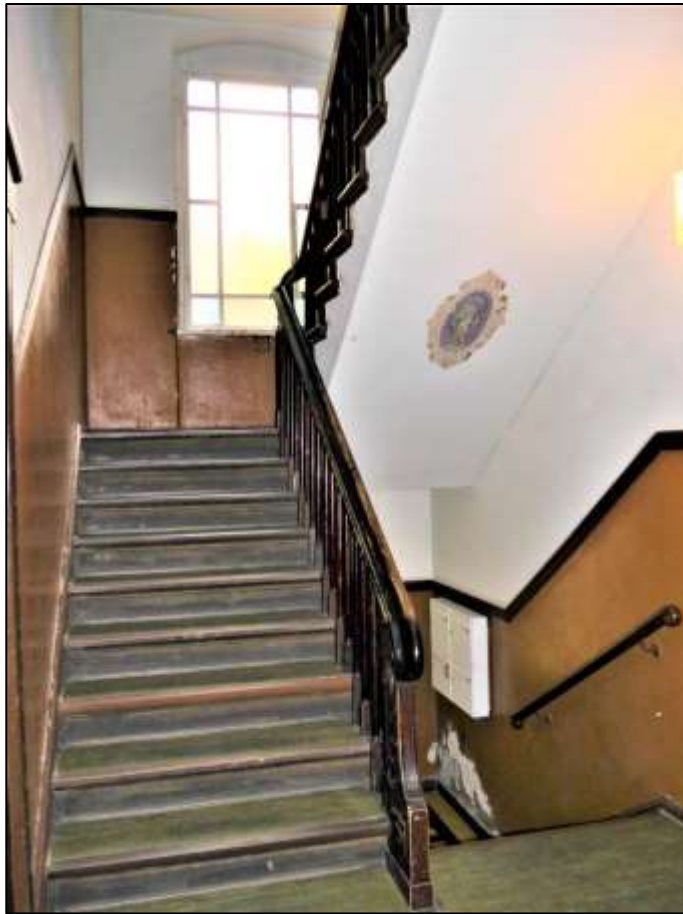
aufgehendes Treppenhaus im Vorderhaus
