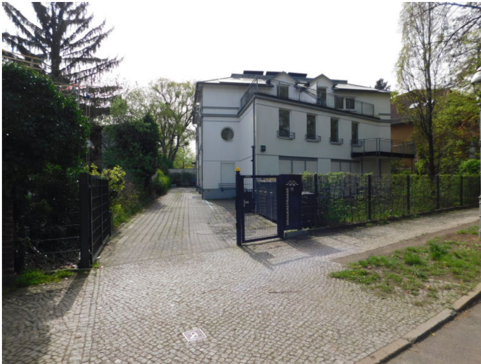
Brauerstraße 15 in 12209 Berlin-Lichterfelde - straßenseitige Gebäudeansicht und WE Nr. 6 im 1. Obergeschoss -
