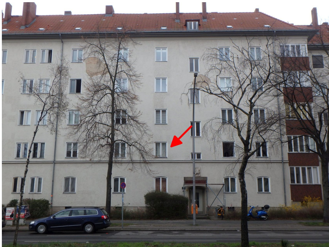
Mehrfamilienwohnhaus Westansicht (Straßenansicht Grazer Damm)
