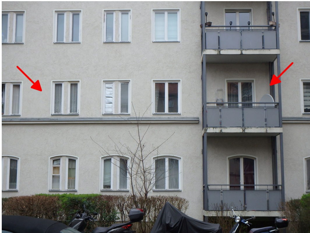
Mehrfamilienwohnhaus sowie Eigentumseinheit Nr. 206 Ostansicht
