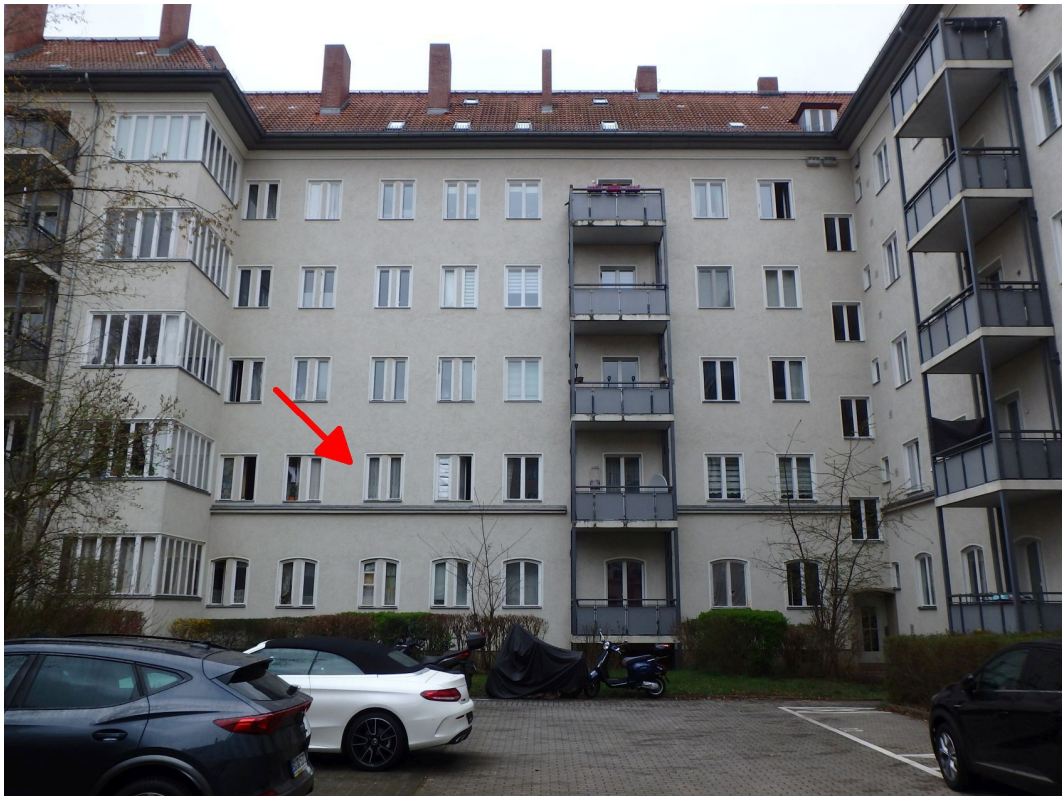
Mehrfamilienwohnhaus Ostansicht (Hofansicht)
